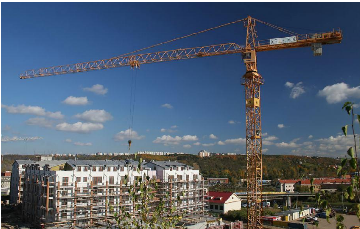
Slika 12. Kran koji svojom veličinom pokriva cijelo gradilište
