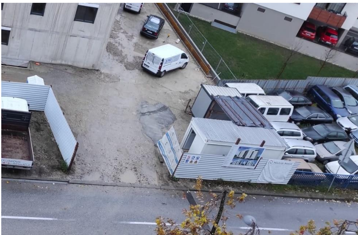
Slika 16. Gradilišni kontejneri s uredom i prostorijom za odmor radnika
