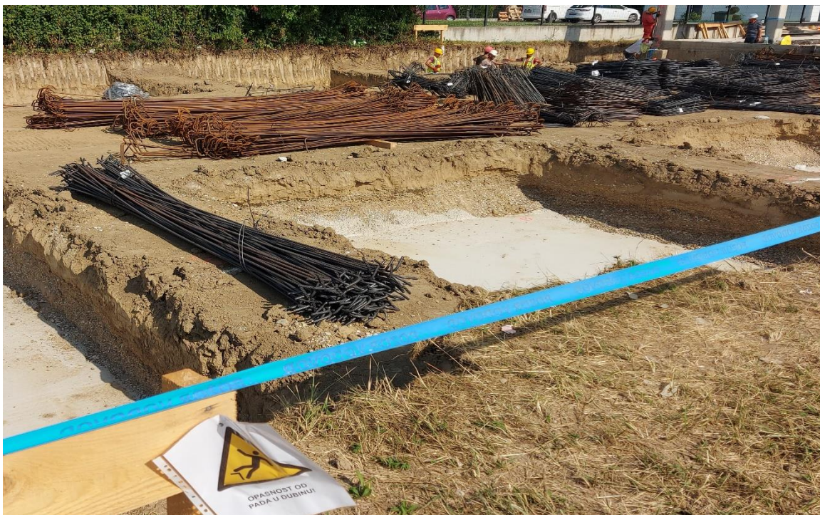
Slika 4. Materijal pripremljen za ugradnju
