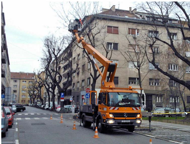
Slika 7. Rad s hidrauličnom dizalicom
