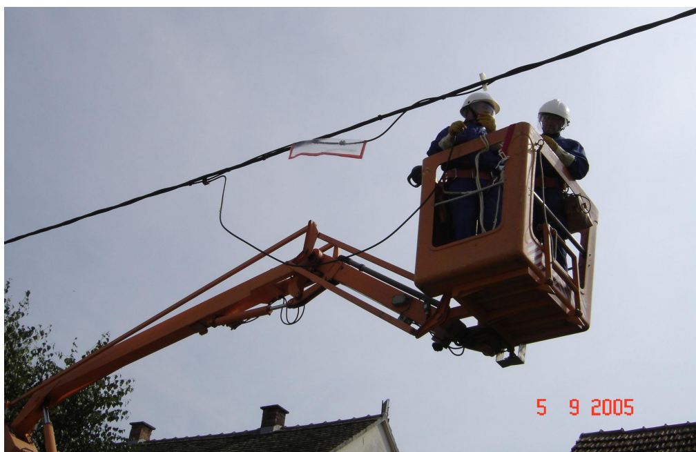
Slika 21. Postavljanje premosnice [Vlastiti izvor]
