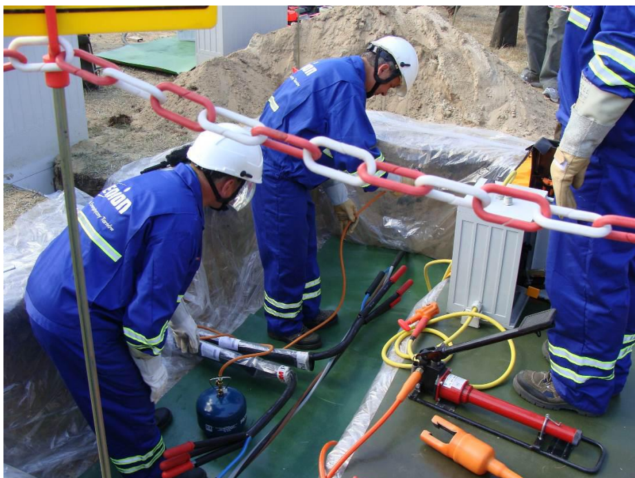
Slika 27. Kako se mora pripremiti radno mjesto za RPN na podzemnim kabelima [Vlastiti izvor]
