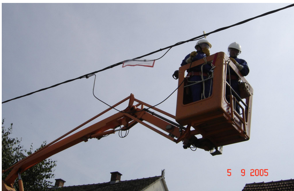
Slika 21. Postavljanje premošnice [Vlastiti izvor]
