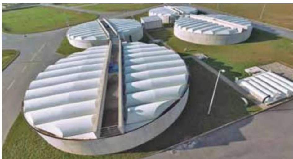
Slika 16. Prethodni i naknadni zgušnjivači mulja [11]
