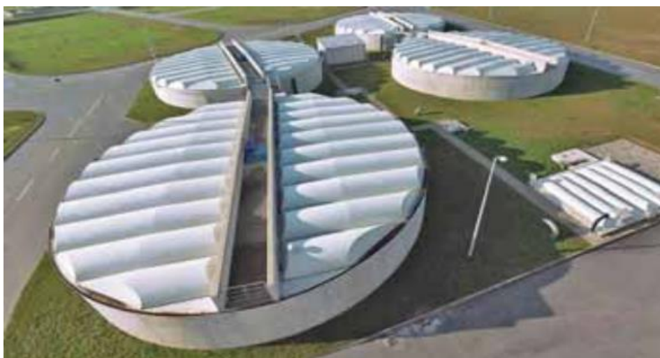
Slika 16. Prethodni i naknadni zgušnjivači mulja [11]
