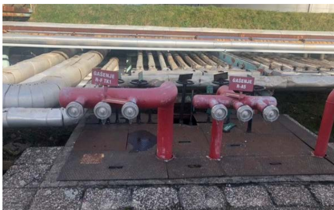
Slika 11. Polustabilni sustav za gašenje požara pjenom.[5]
