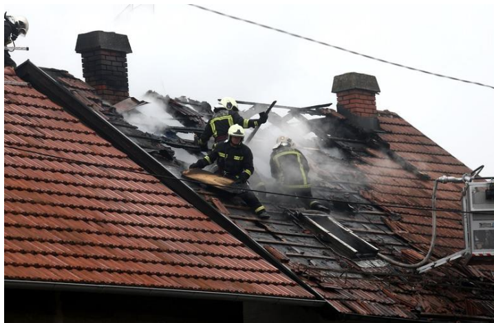
Slika 6. Gašenje drvene konstrukcije krova [10]
