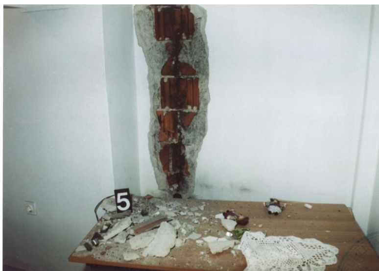
Slika 22. Podžbukno preopterećenje strujnog kabela [12]
