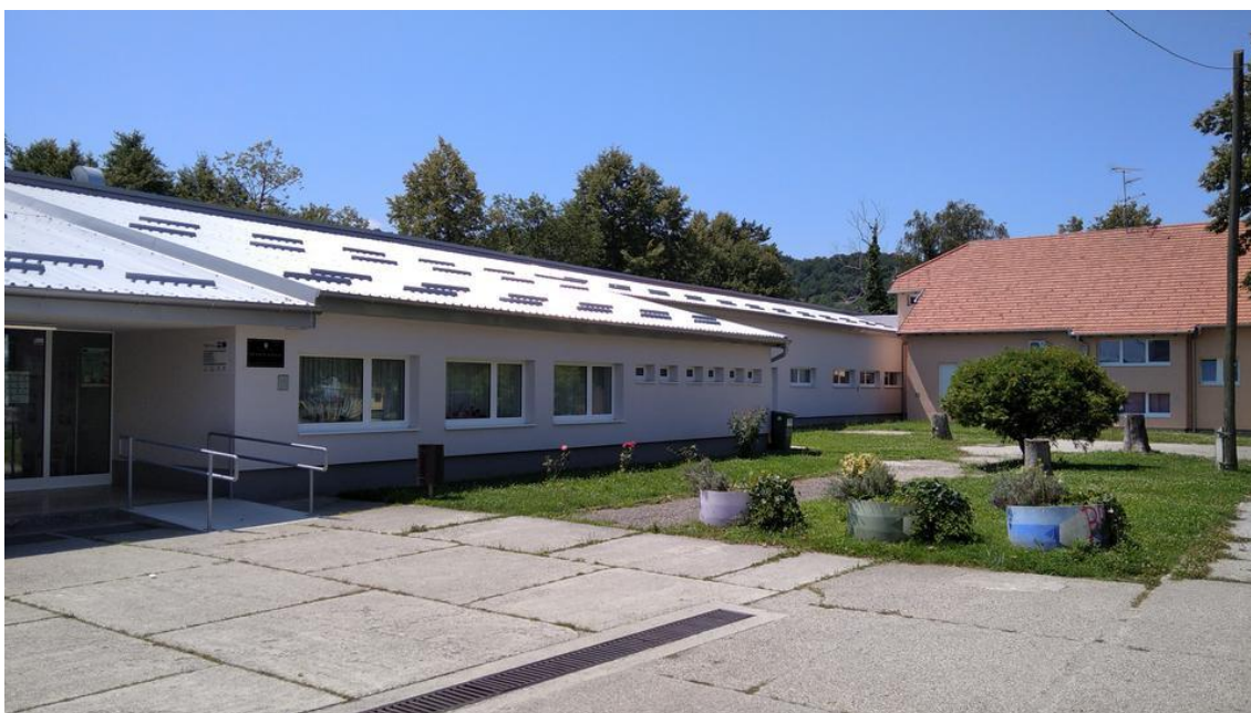
Slika 8: Matična škola OŠ Sveta Nedjelja nakon energetske obnove zgrade
