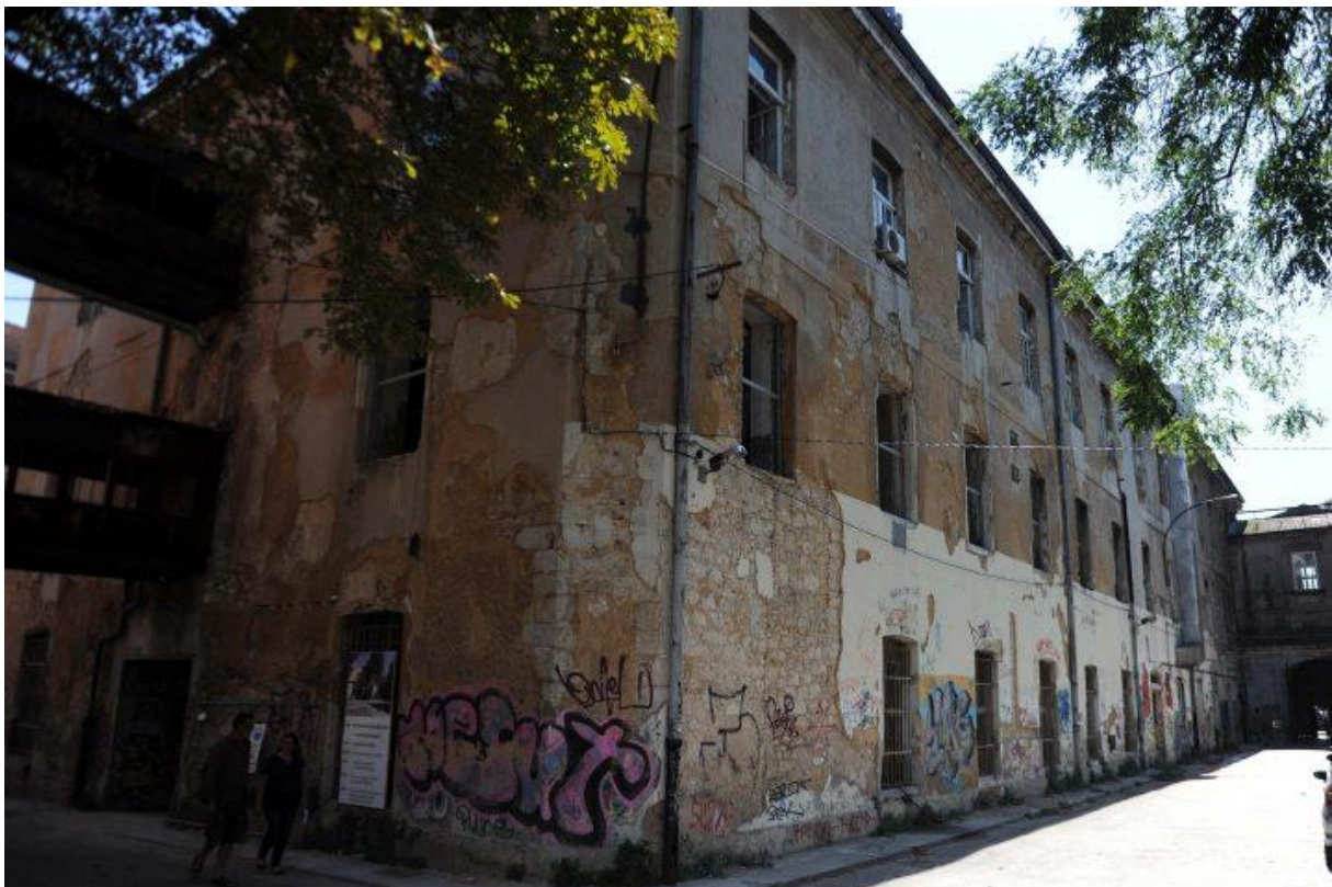
Slika 10. H-objekt prije rekonstrukcije[19]
