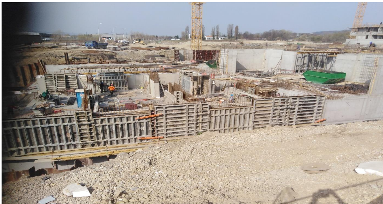
Slika 9: Početak gradnje nadzemnog dijela
