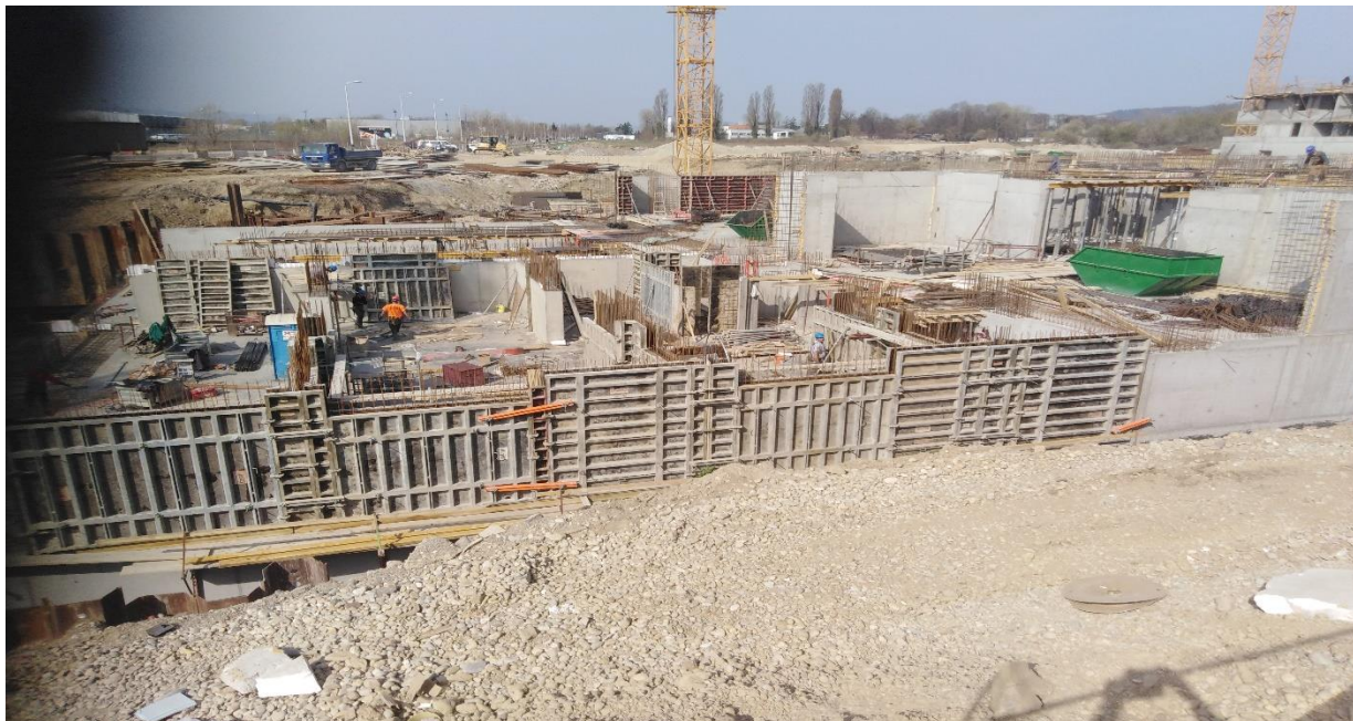
Slika 9: Početak gradnje nadzemnog dijela
