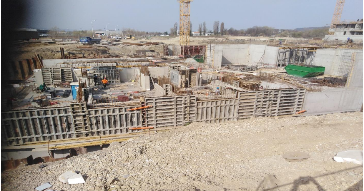
Slika 9: Početak gradnje nadzemnog dijela
