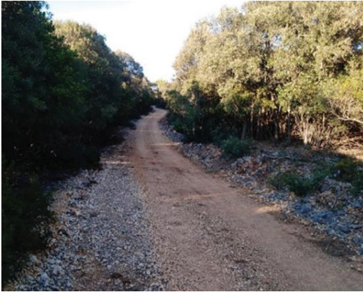
Slika 19. Šumska protupožarna cesta [11]
