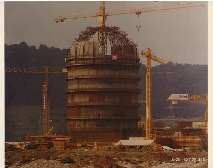
Slika 2 Završna montaža reaktorske zgrade u rujnu 1975. godine [17] PRISTUPLJENO 29.6.2022.
