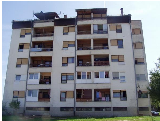
Slika 17. Stambena zgrada prije energetske obnove
