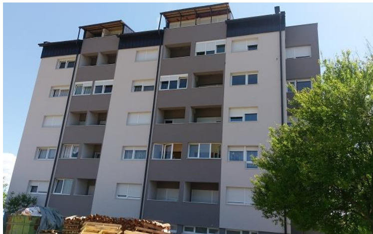
Slika 18. Stambena zgrada poslije energetske obnove
