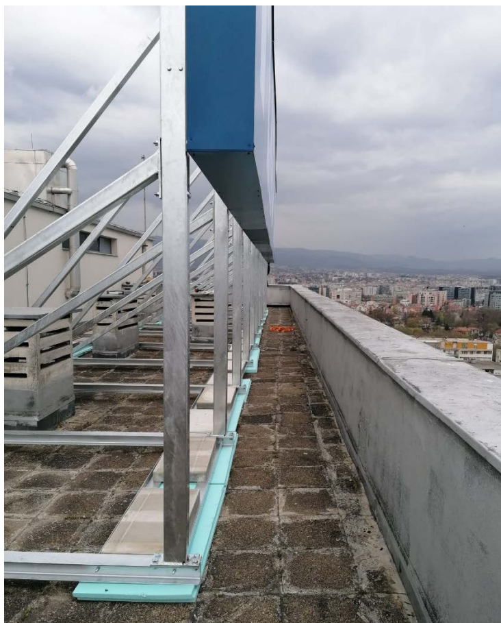
Slika 21. Spuštena reklama na krovu
