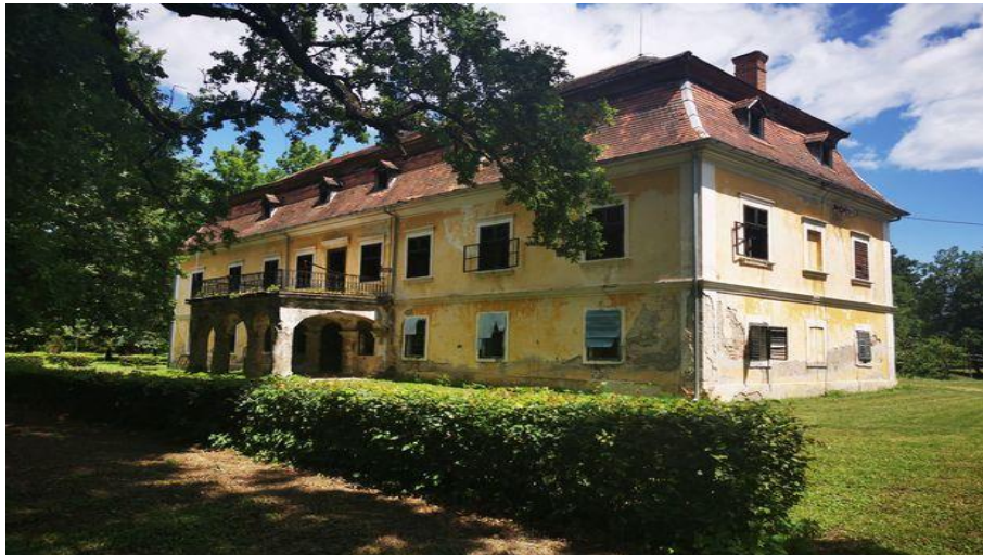
Slika 11 Trenkov dvorac u Trenkovu
