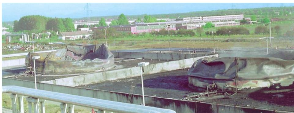
Slika 3. Spremniči goriva u TE-TO Osijek nakon požara uzrokovanog ratnim razaranjem [10]
