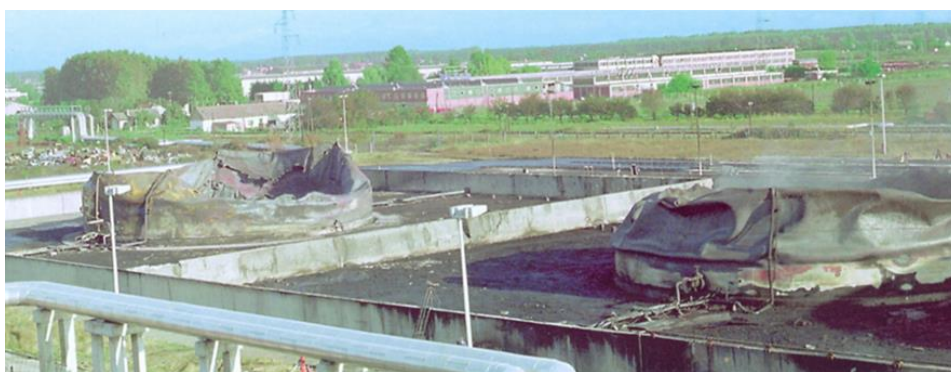
Slika 3. Spremnici goriva u TE-TO Osijek nakon požara uzrokovanog ratnim razaranjem [10]
