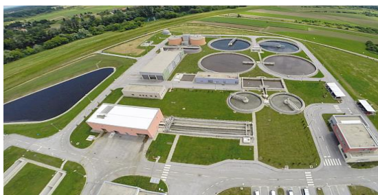
Slika 4. Uređaji za pročišćavanje otpadnih voda u Karlovcu [7]
