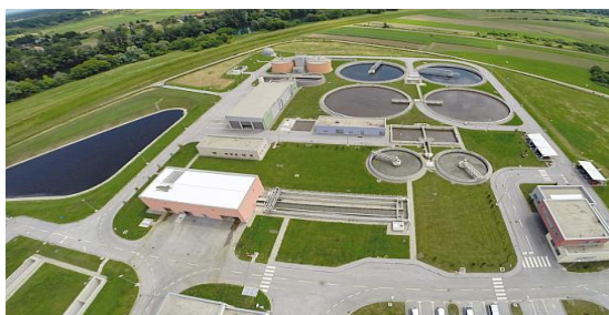
Slika 4. Uređaji za pročišćavanje otpadnih voda u Karlovcu [7]
