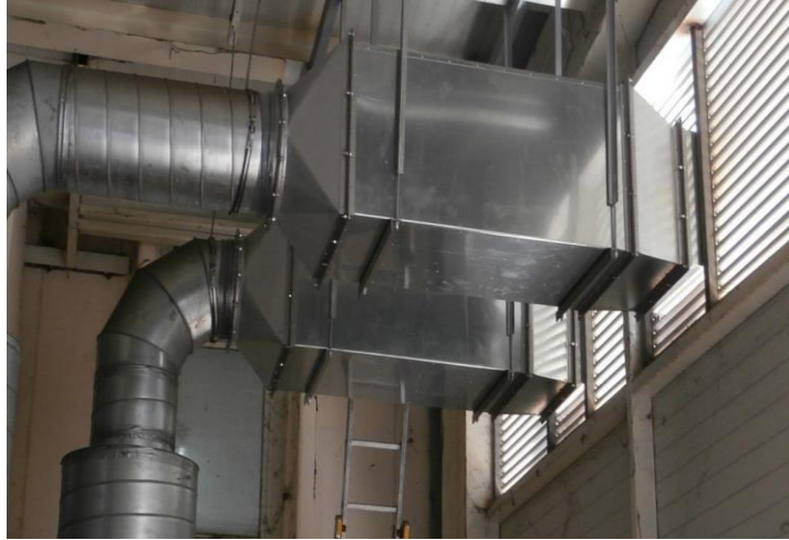
Slika 7. Prigušivači buke u ventilacijskom sustavu
