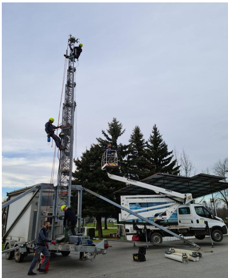
Slika 3. Izvođenje radova na anteskom stupu
