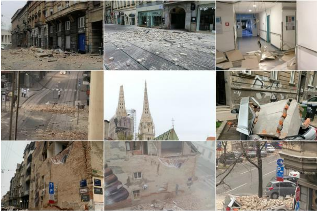
Slika 4. Materijalna šteta zagrebačkog potresa 2020. godine
