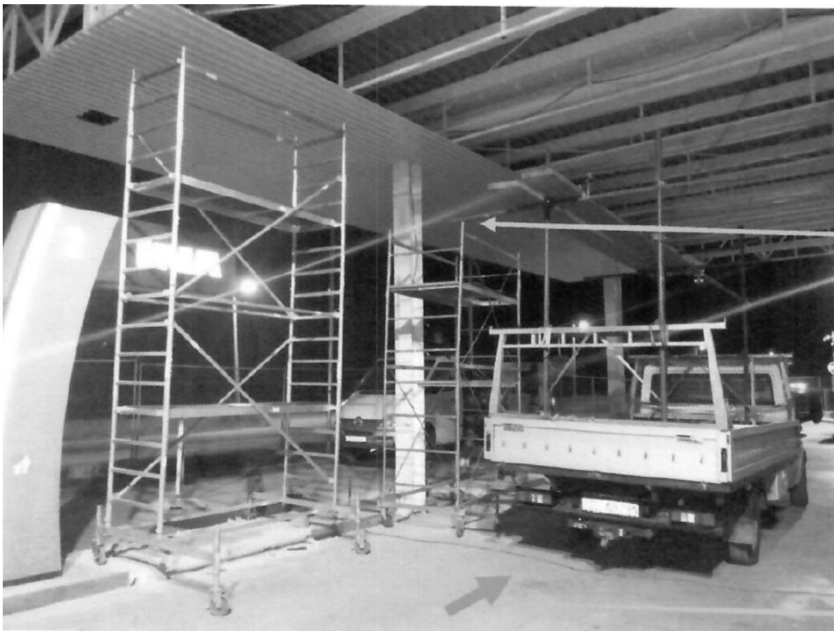
Slika 7 Incident na benzinskoj postaji [11]
