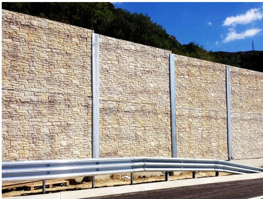
Slika 14 Zid za zaštitu od buke
