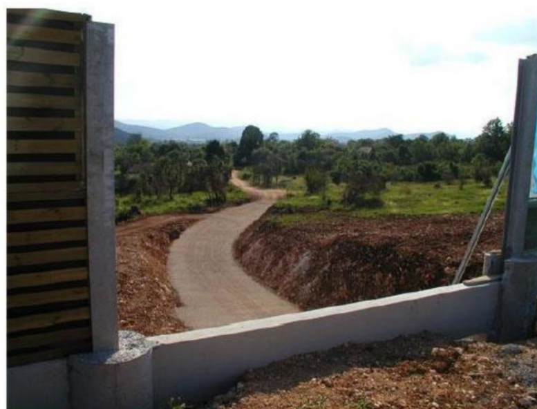
Slika 21 čelični profili i temelji profila
