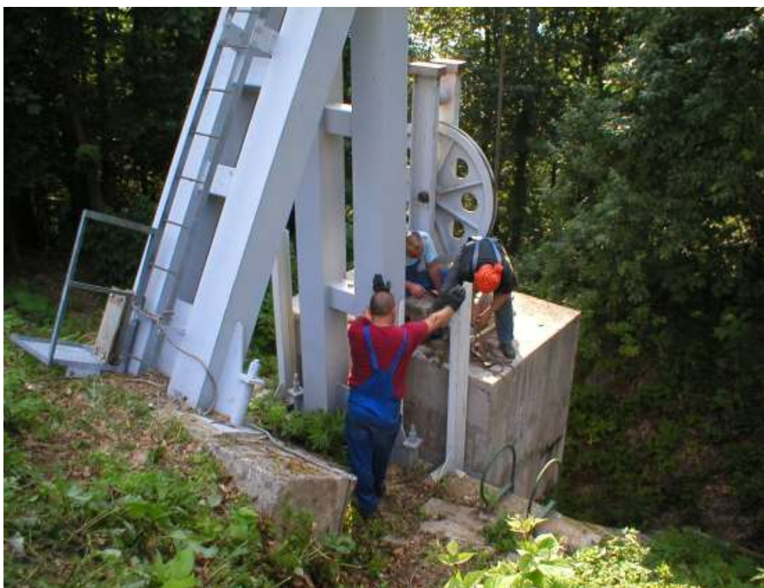
Slika 21 Montaža naprave za podizanje protuutega (3)
