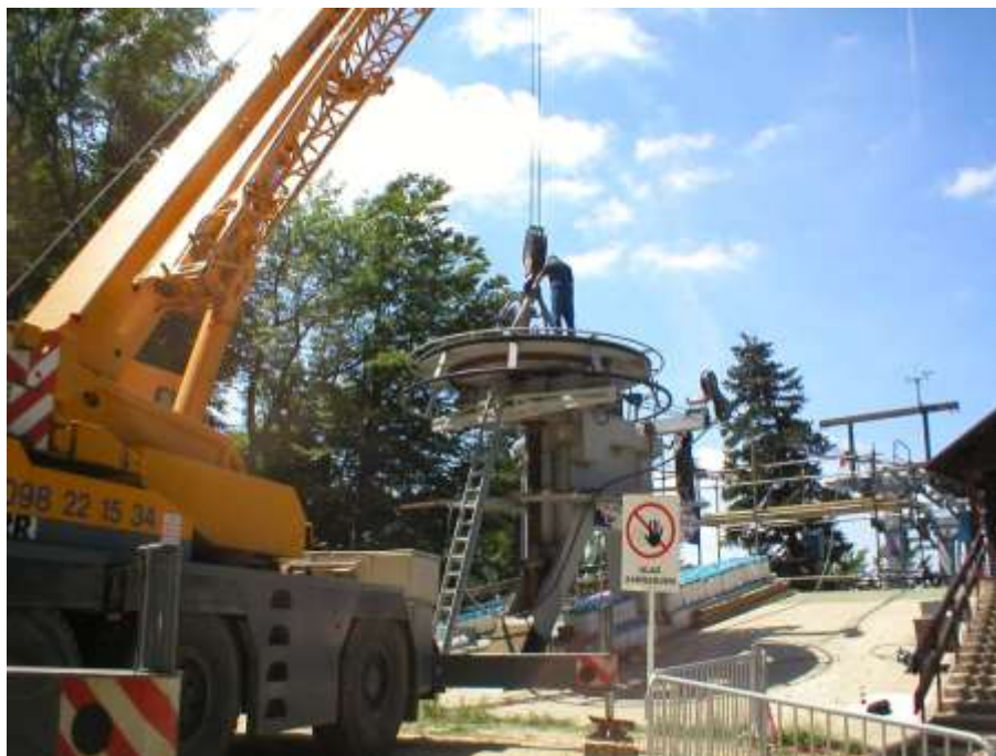
Slika 36. Skidanje kape pogonskog kotača
