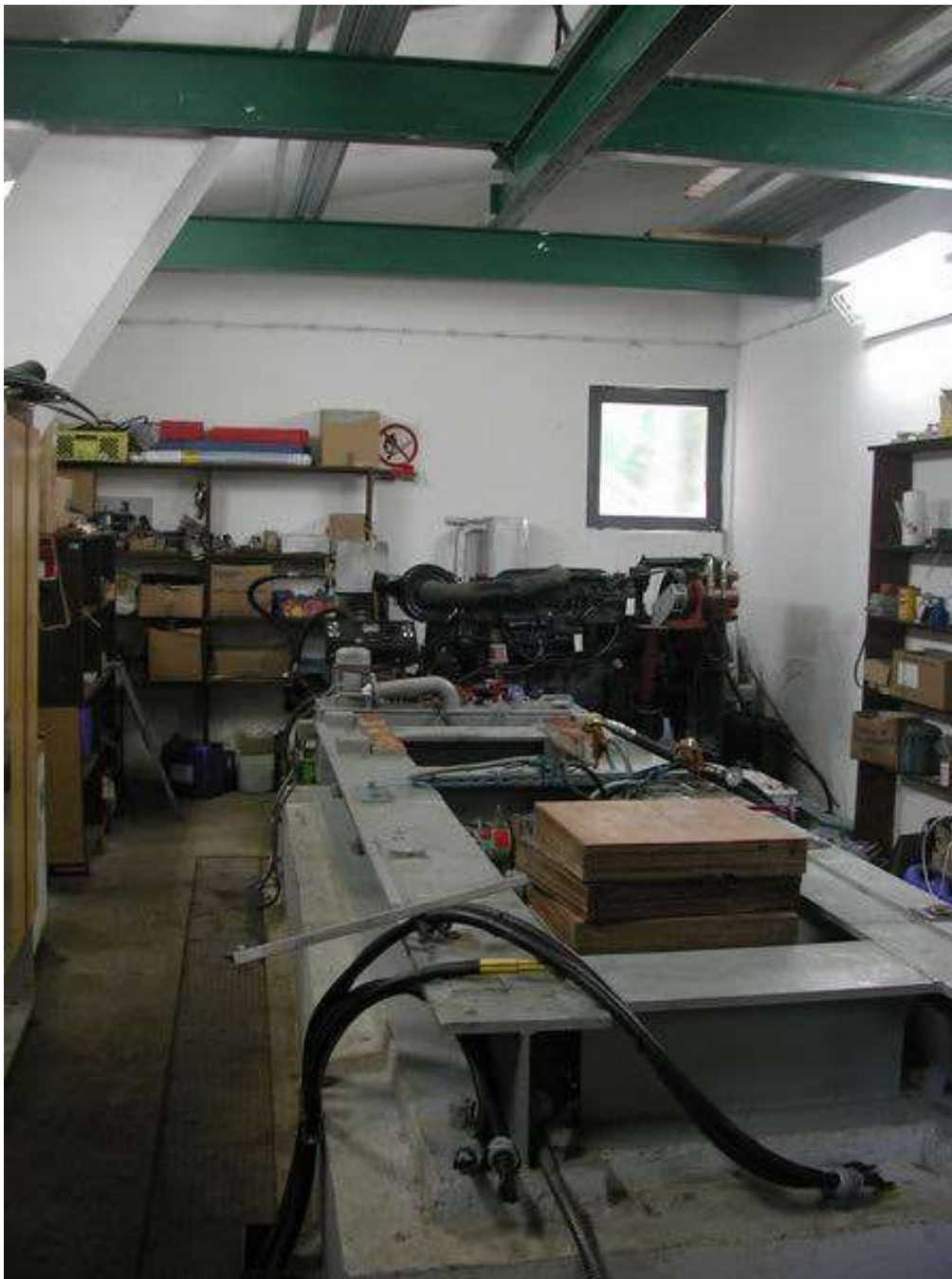
Slika 43 Stanje podzemne strojarnice nakon demontaže
