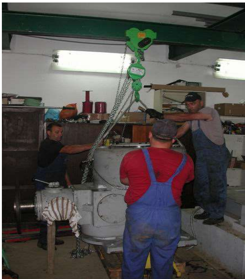
Slika 42 Demontažni postupak u podzemnoj strojarnici (2)
