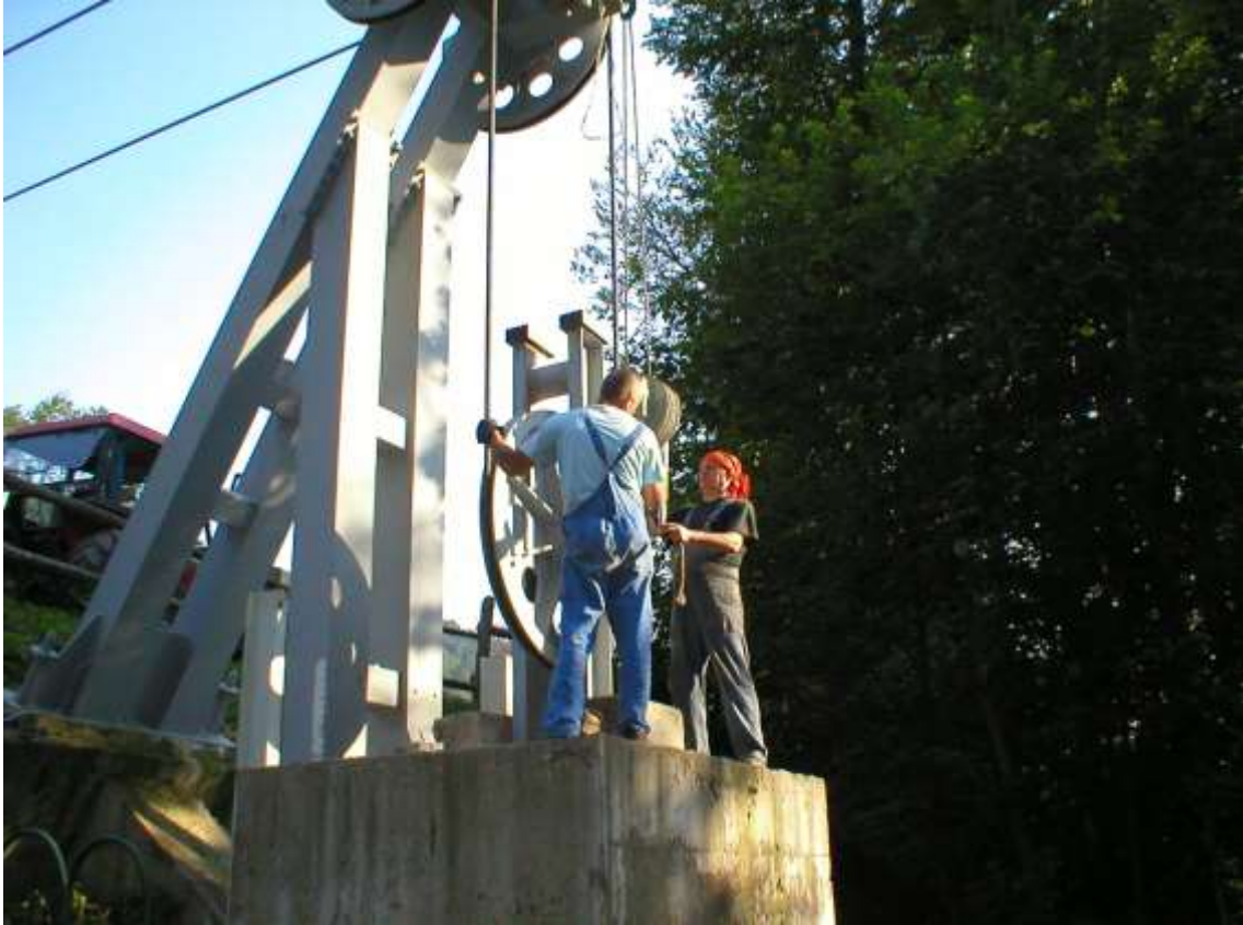
Slika 22 Montaža naprave za podizanje protuutega (4)
