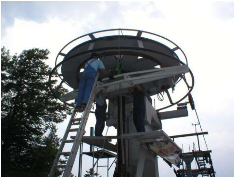
Slika 25 Montaža naprave za preuzimanje užeta (1)
