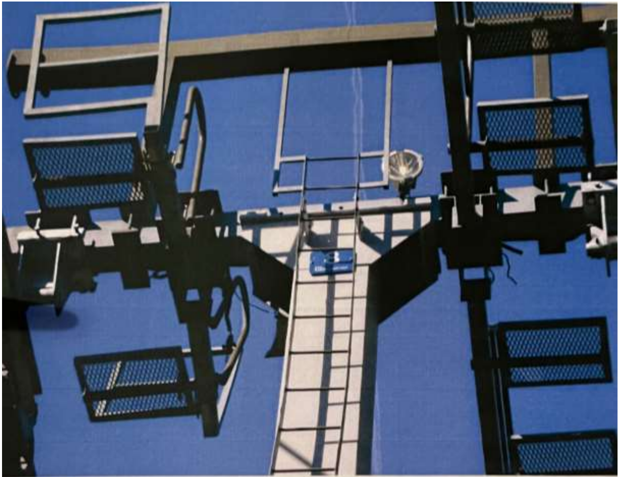
Slika 51 Stup oslobođen od baterijskih sklopova
