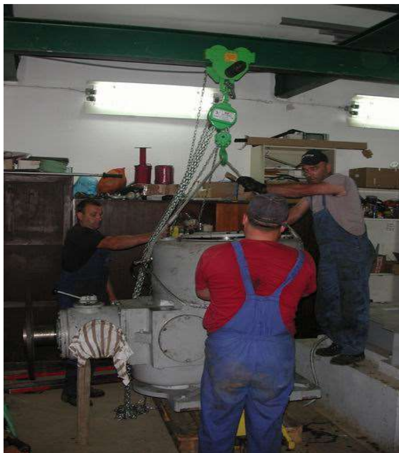
Slika 42 Demontažni postupak u podzemnoj strojarnici (2)
