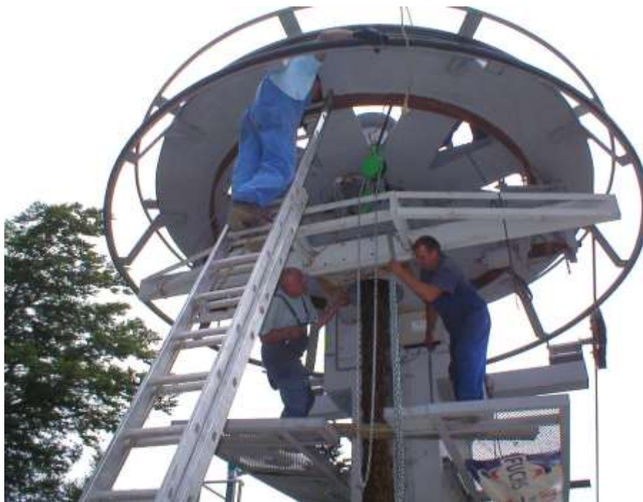
Slika 27 Montaža naprave za preuzimanje užeta (3)
