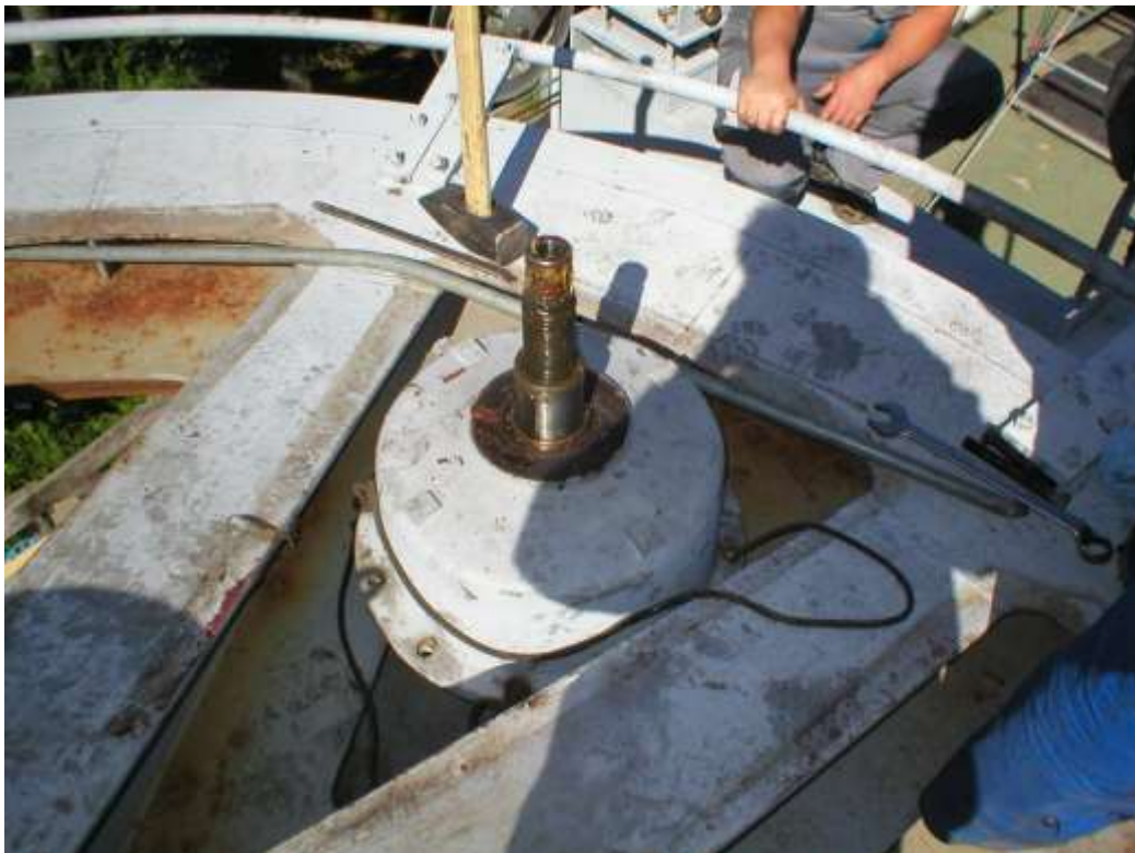
Slika 39 Podizanje dvodijelnog vratila (3)
