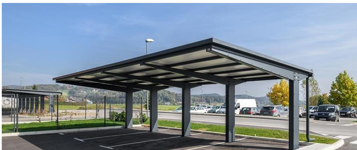
Slika 2. Prikaz konzolne nadstrešnice [2]
