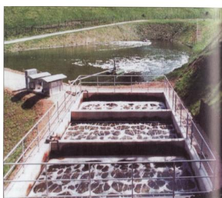
Slika 17. Reaktor za nitrifikaciju
