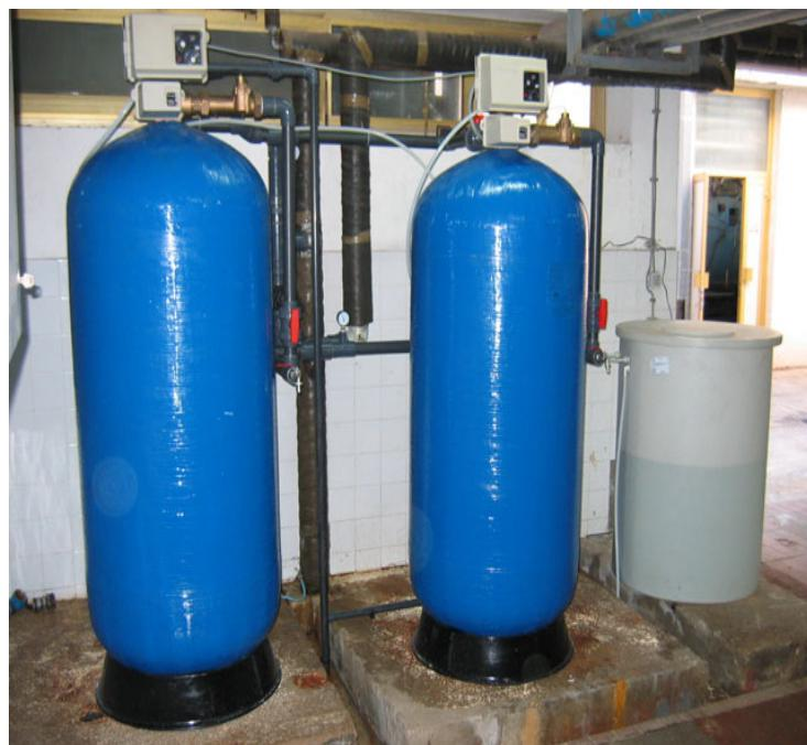
Slika 18. Ionski izmjenjivači
