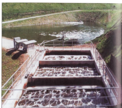
Slika 17. Reaktor za nitrifikaciju
