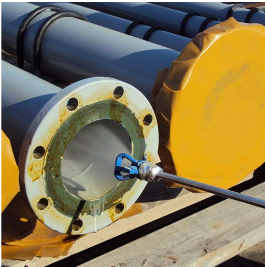
Slika 14. Primjer primjene inhibitora korozije u cjevovodima [29]
