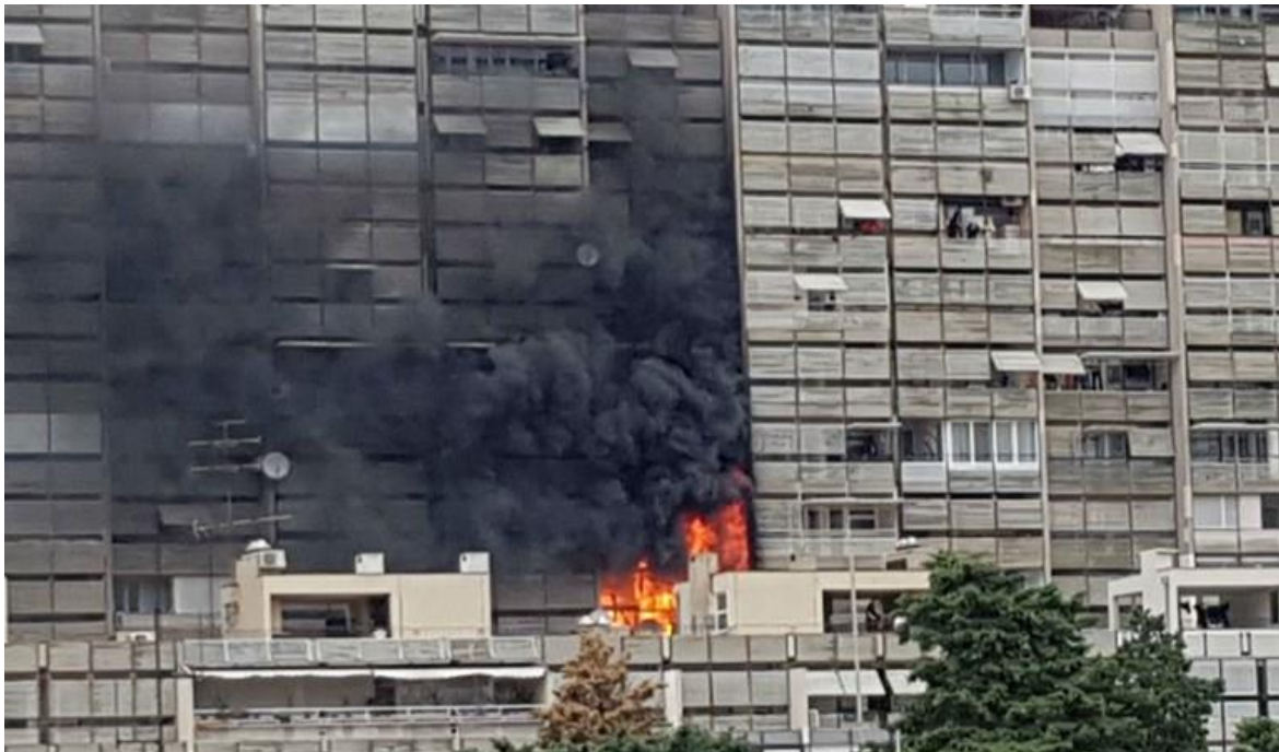
Slika 20. Prikaz požara zgrade iz navedene intervencije; preuzeto iz arhive JVP Split
