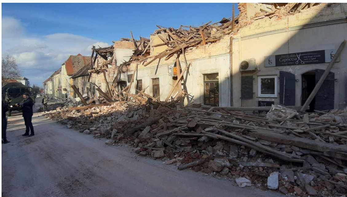
Slika 5. Građevine koje su se srušile na prometnicu [5]
