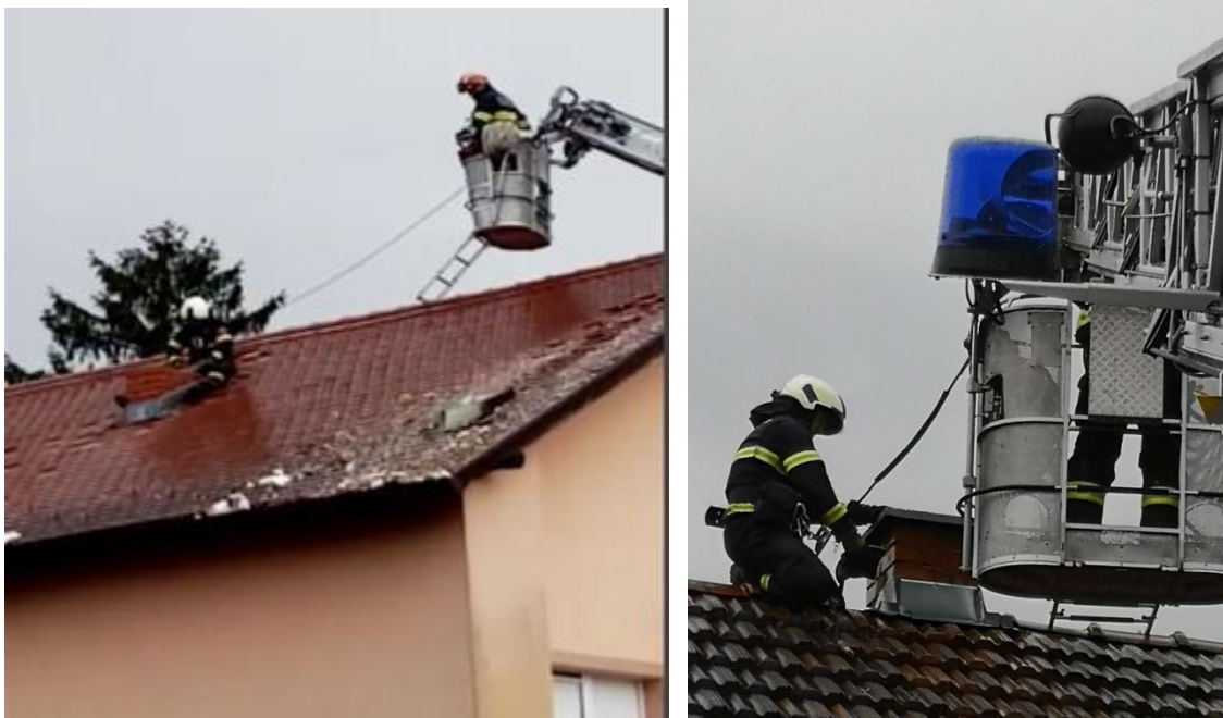
Slika 38. Primjeri osiguranja [17]
