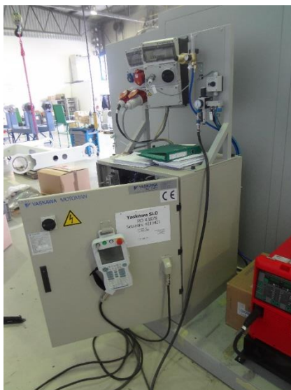
Slika 27. Upravljački ormar s džojstikom i MIG/MAG aparatom za zavarivanje [17]
