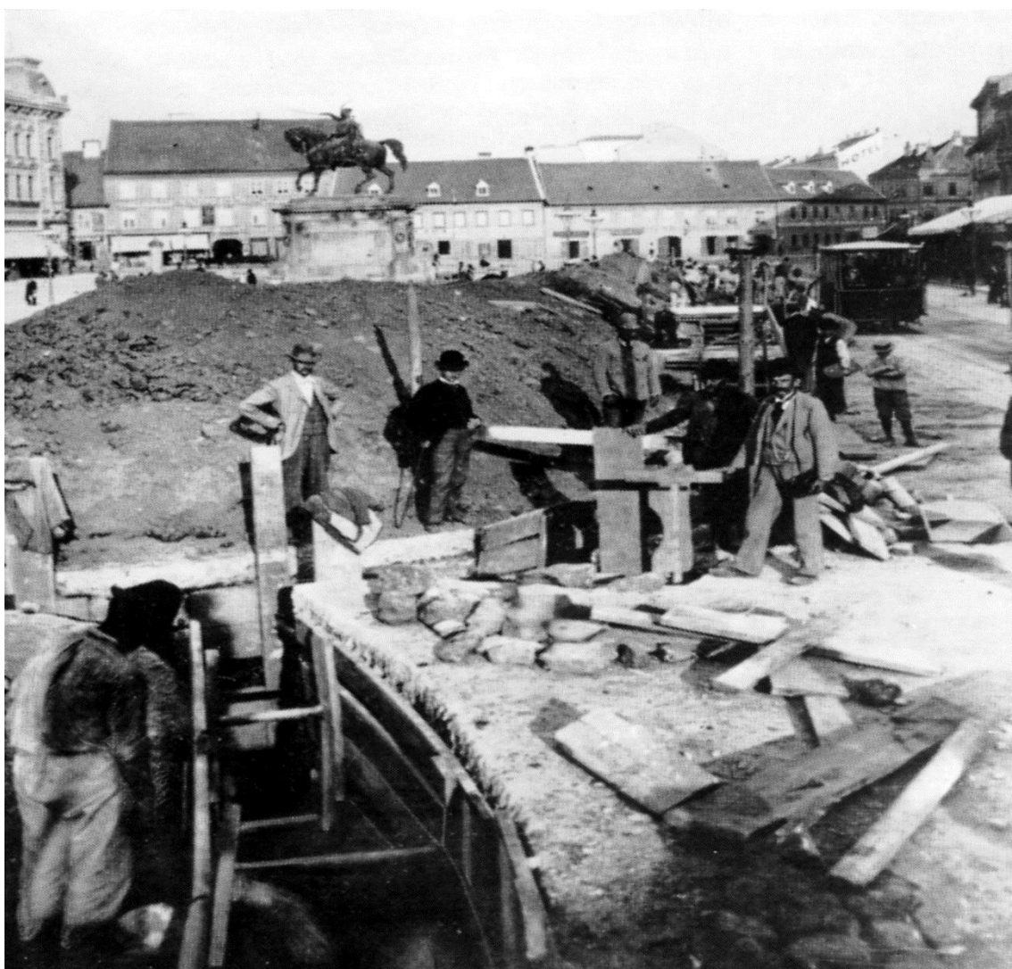
Slika 1. Gradnja kanala na Jelačićevom trgu 1898.godine [2]
