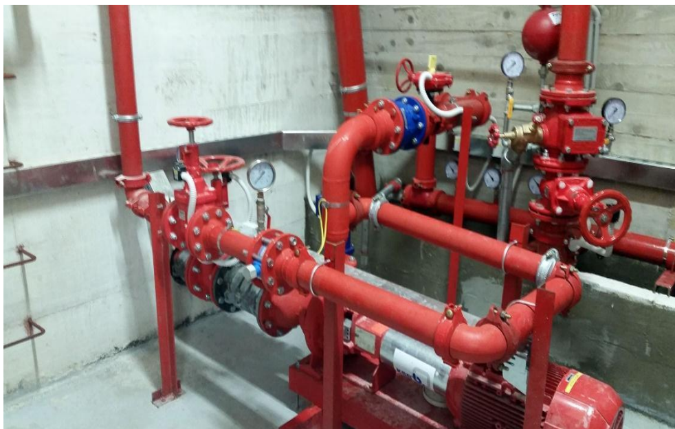
Slika 22. Prostorija sa uređajem za povišenje tlaka [14]
