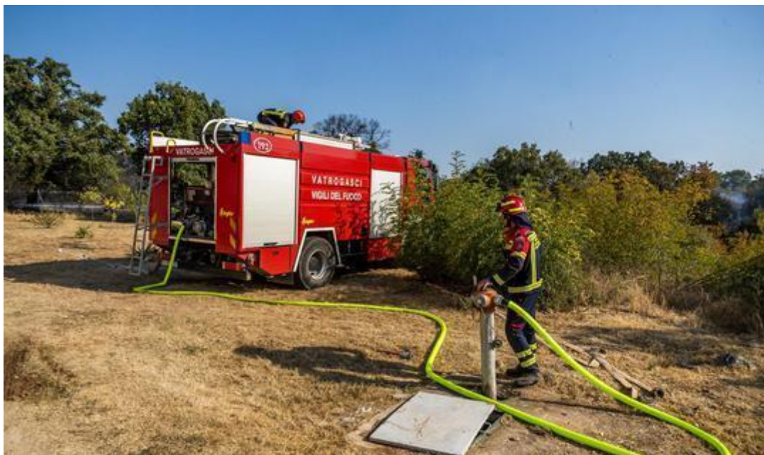
Slika 27. Vatrogasno vozilo priključeno na podzemni hidrant[24]
