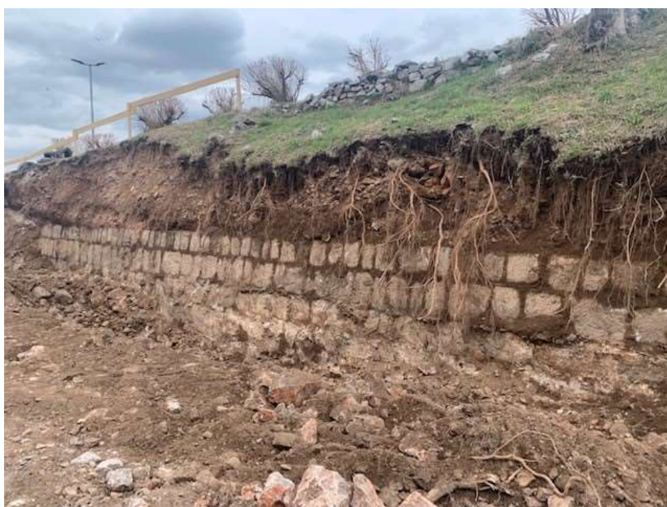
Sl.6. Fragmenti sanacije starog odvoda bujice u Senju
