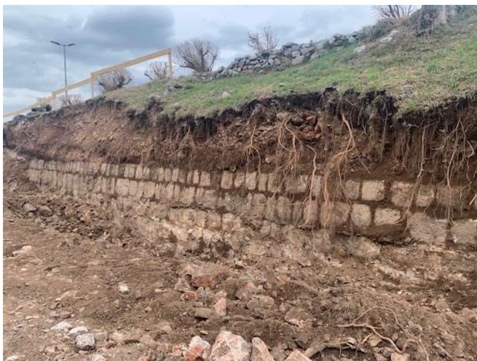
Sl.6. Fragmenti sanacije starog odvoda bujice u Senju [ https://www.lika-online.com/sanira-se-stari-odvod-bujica-u-senju/ ]
