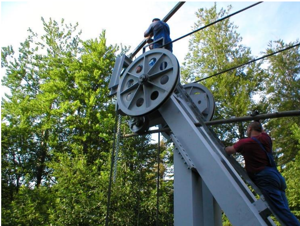
Slika 23. Montaža naprave za podizanje protuutega [7]
