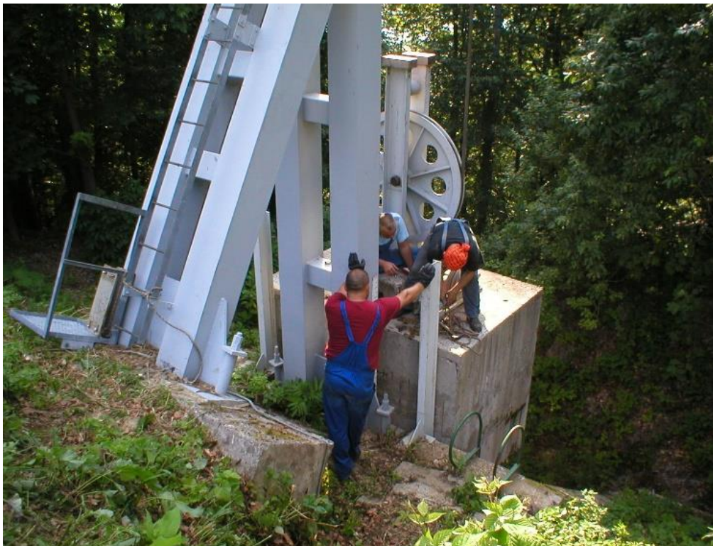
Slika 25. Montaža naprave za podizanje protuutega (2) [7]
