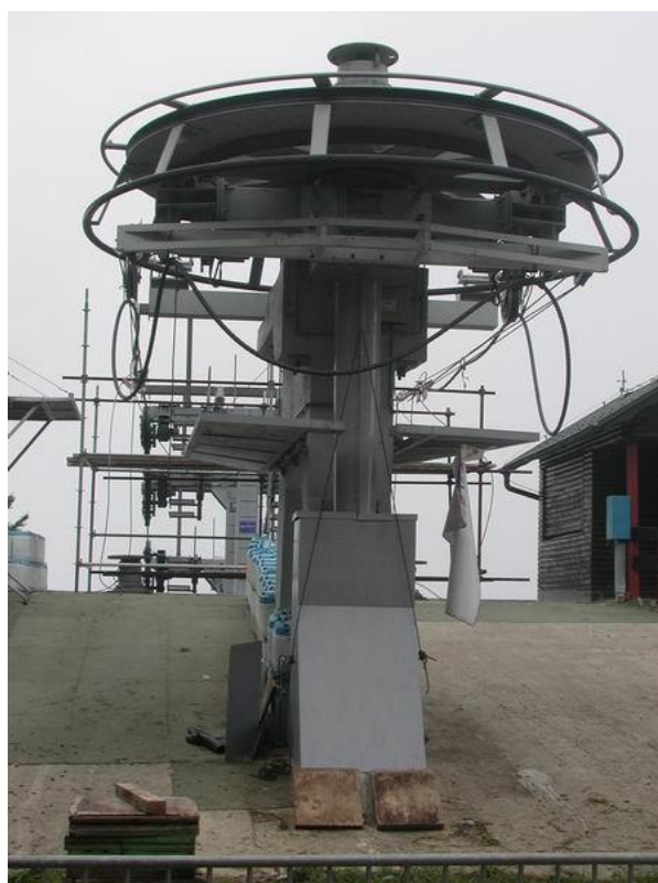
Slika 51. Montiran pogonski okretni kotač [7]
