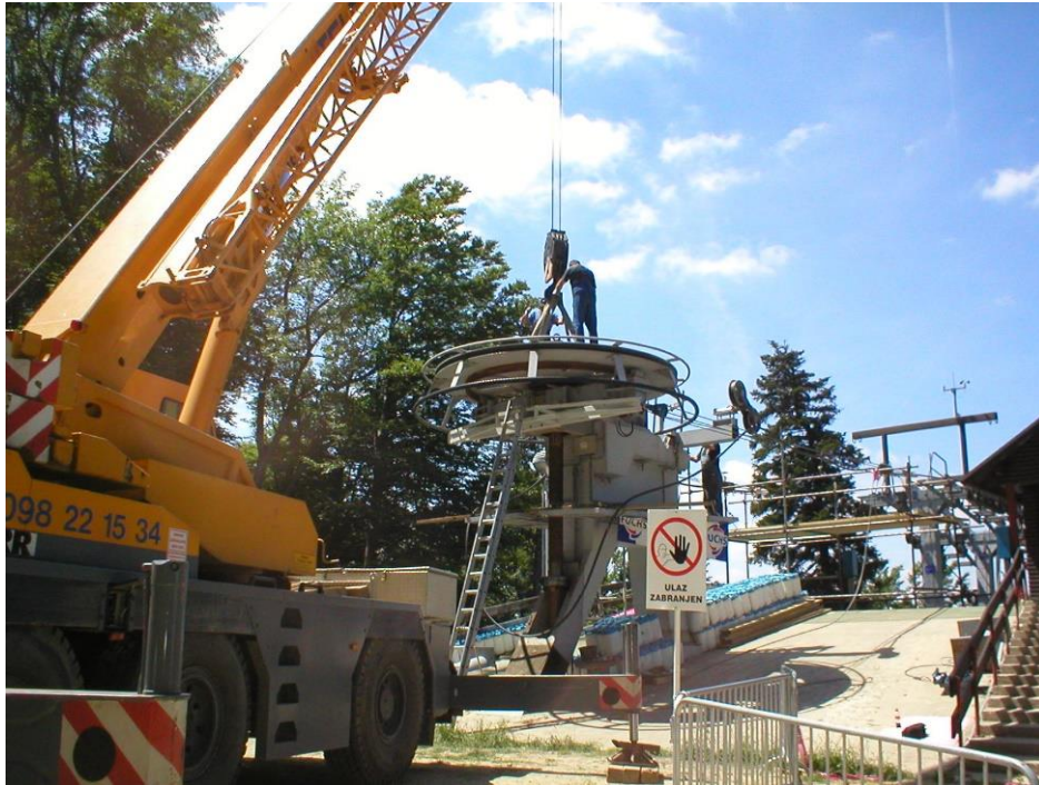
Slika 41. Podizanje vratila autodizalicom [7]
