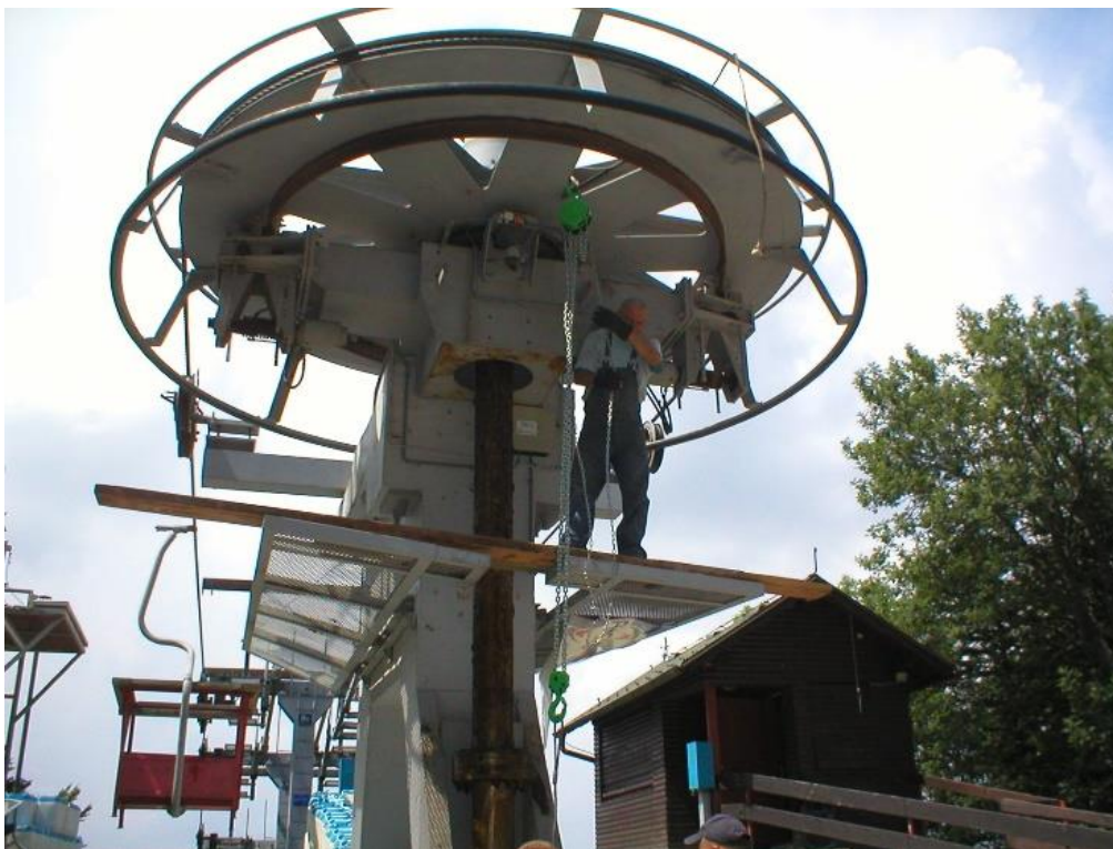
Slika 28. Montaža naprave za preuzimanje nosivog užeta s pogonskog kotača (2) [7]
