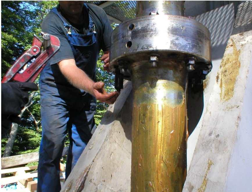
Slika 39. Demontaža prirubničkog spoja [7]
