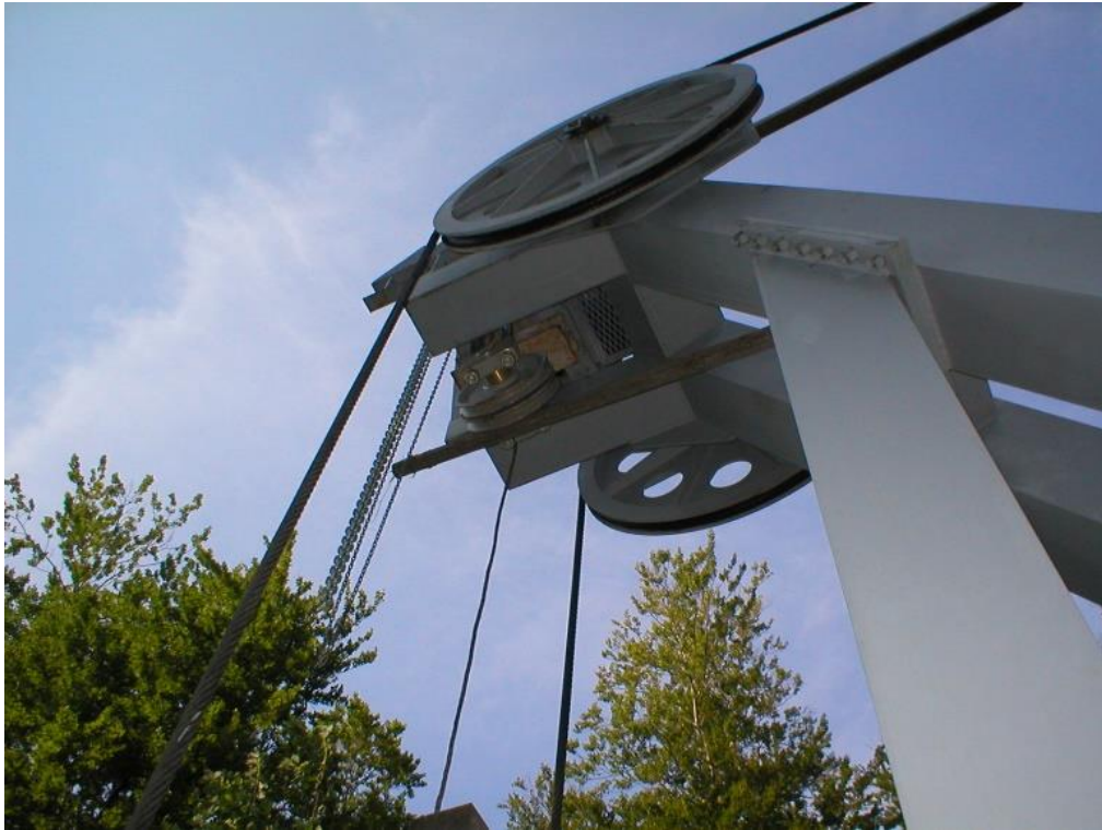
Slika 24. Montaža naprave za podizanje protuutega (1) [7]
