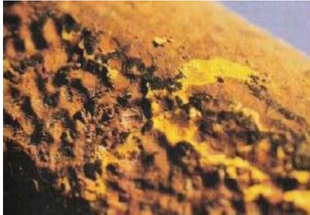
Slika 7. Plinska korozija ( http://bs.scribd.com/doc/219168839/Kotlovski-Materijali-i-Opterecenja , Pristupljeno 20.12.2022.)
