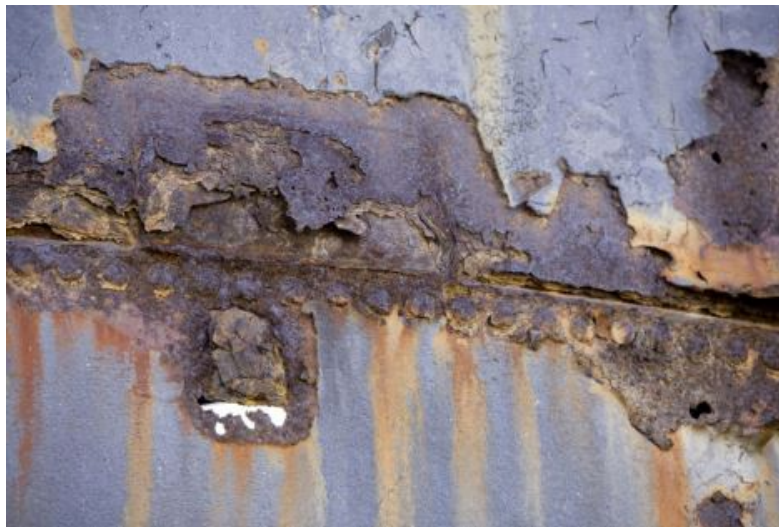
Slika 15. Potpovršinska korozija
