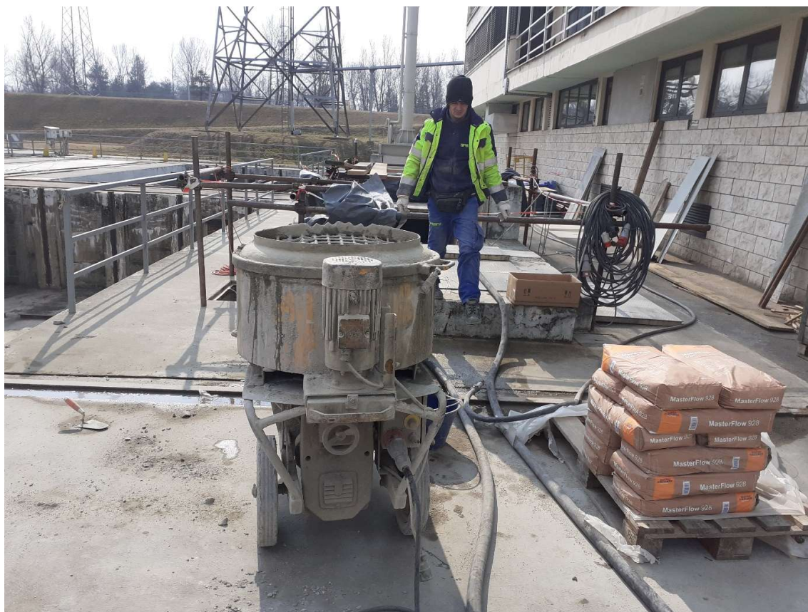
Slika 4.28 Injektiranje podložnog betona visokotlačnom pumpom
