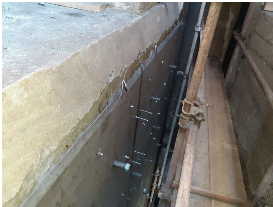
Slika 4.26 Brtveća stijena nakon zavarivanja
