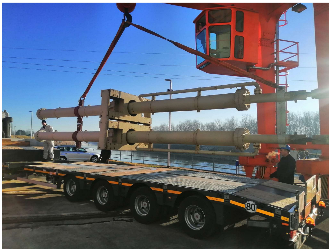
Slika 4.18 Utovar servomotora na labudicu za transport
