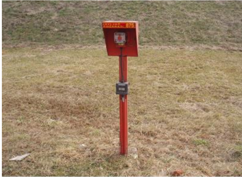
Slika 2: Ručni javljač požara [10]
