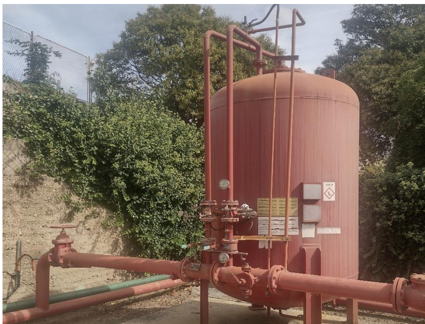
Sl. 6. Spremnik za pjenilo i mješač vode i pjenila [Vlastita fotografija]
