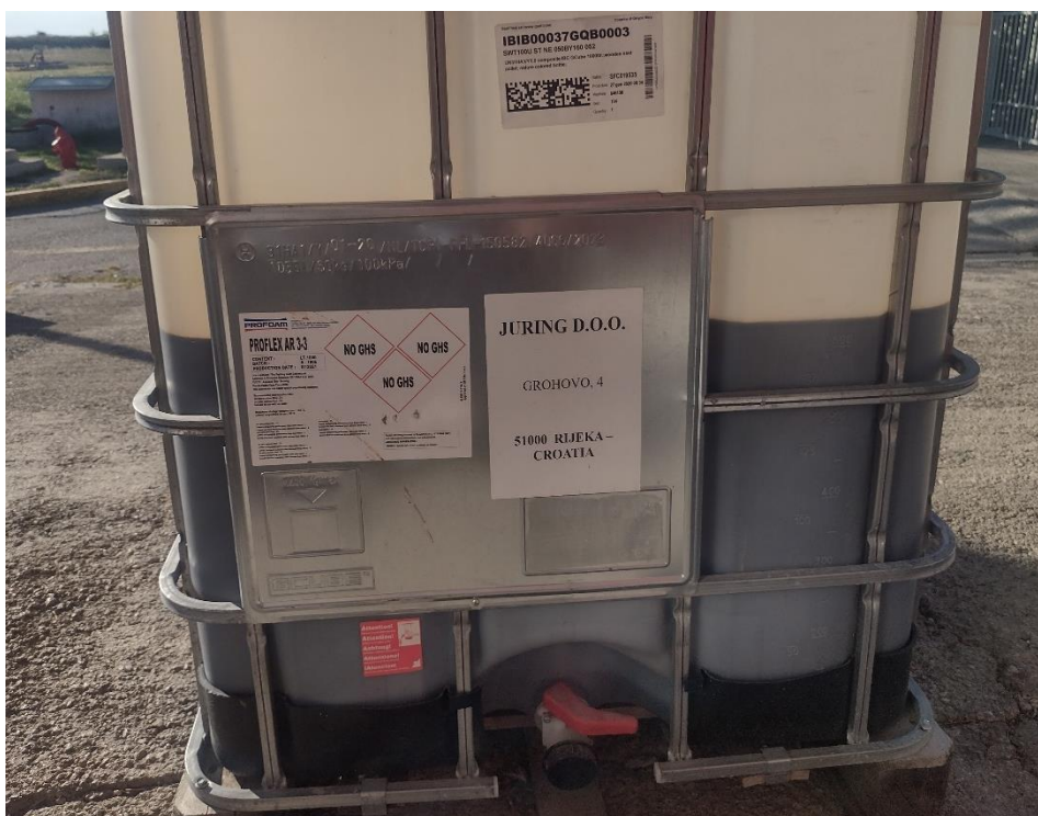
Sl. 11. Spremnik Fluorproteinskog pjenila koje stvara vodeni film FFFP [Vlastita fotografija]
