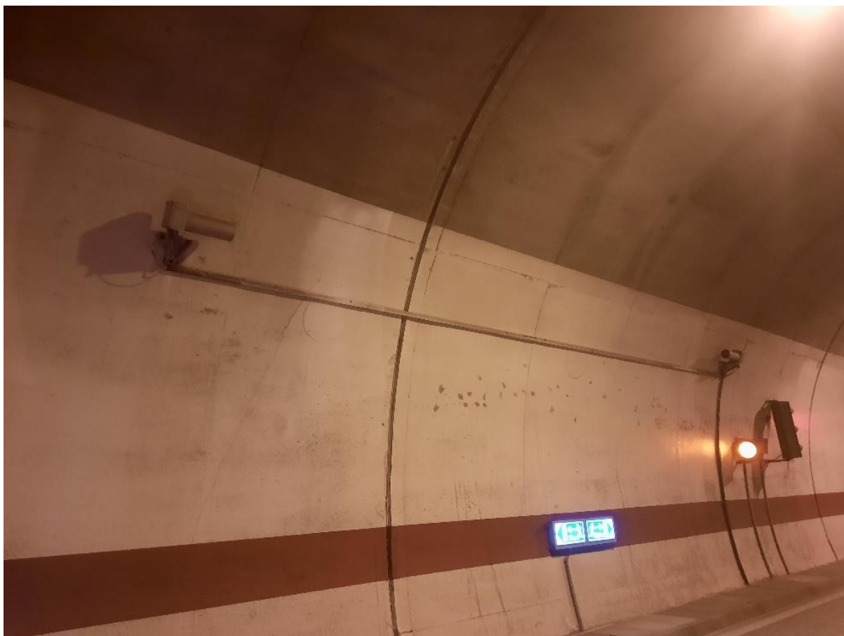
Slika 14. Senzori vidljivosti i CO (vlastiti izvor)
