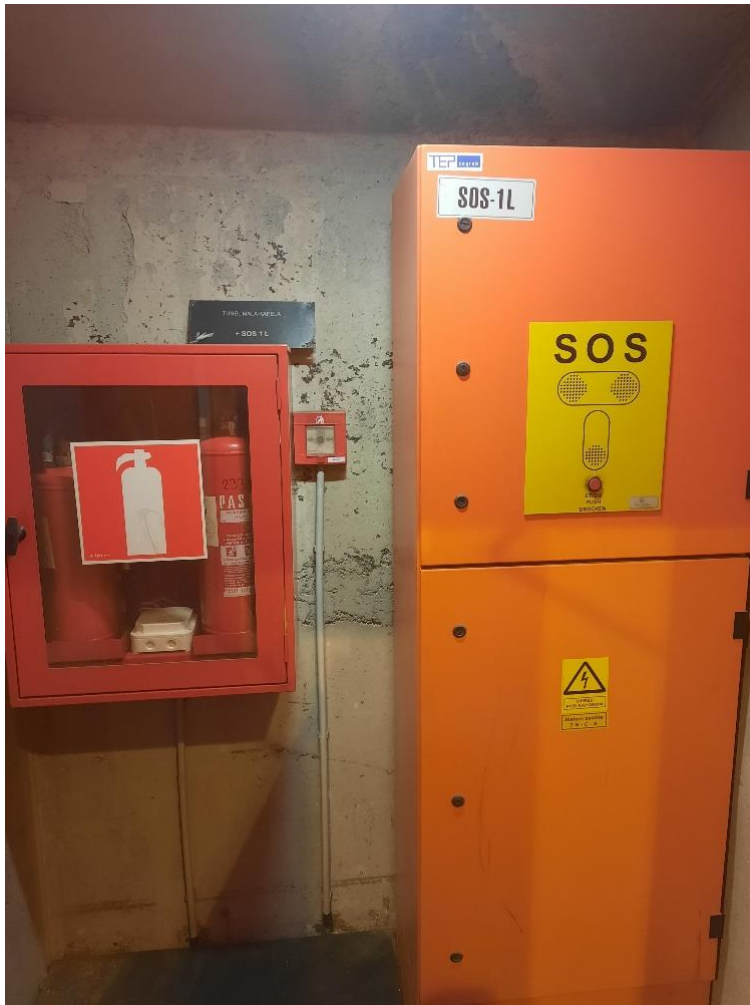
Slika 10. SOS niša sa vatrogasnim aparatima i SOS telefonom (vlastiti izvor)
