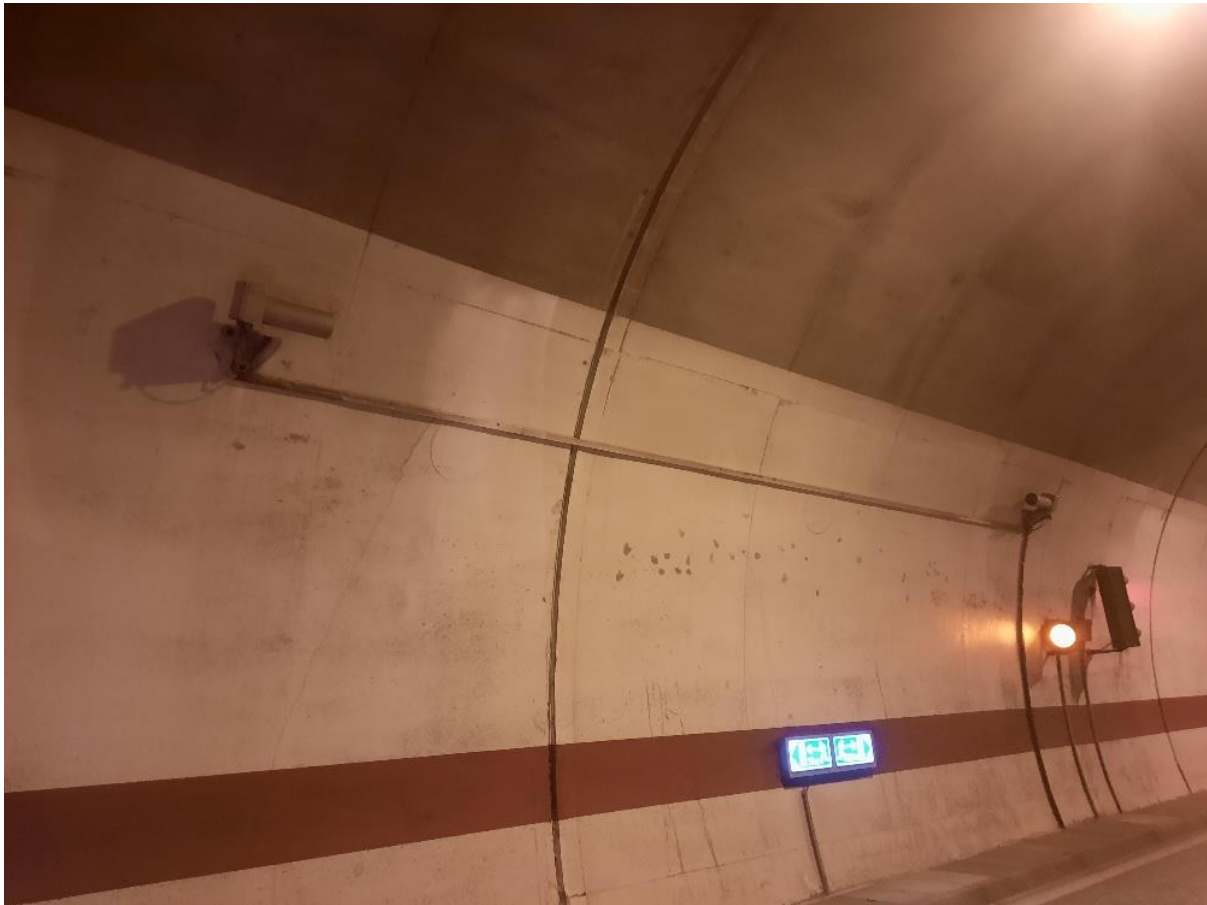
Slika 14. Senzori vidljivosti i CO (vlastiti izvor)
