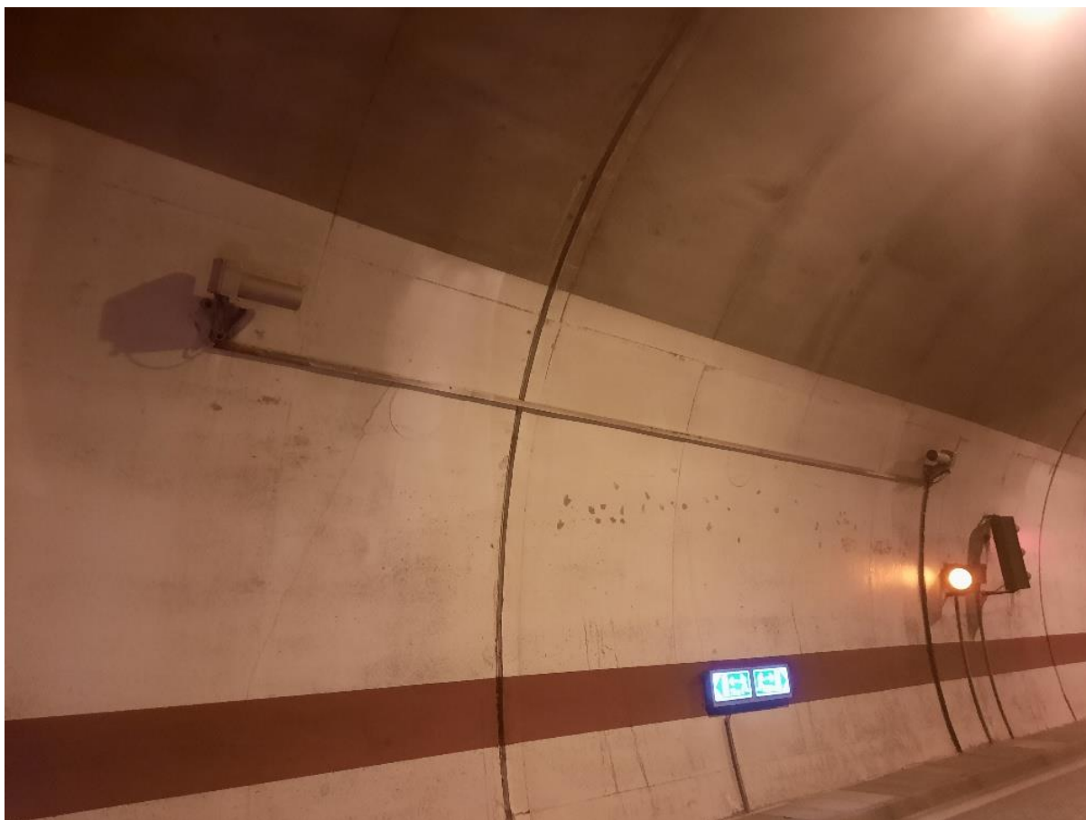
Slika 14. Senzori vidljivosti i CO (vlastiti izvor)
