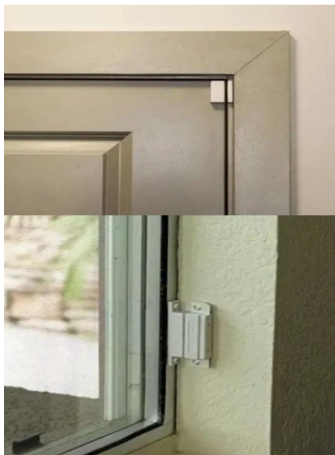
Slika 1. Sastoji se od dva dijela od kojih je jedan magnetski kontakt pričvršćen na vrata (gore) i prozor (dolje) [6]
