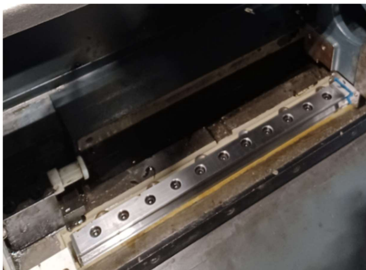
Slika 71. Prikaz montiranih novih vodilica
