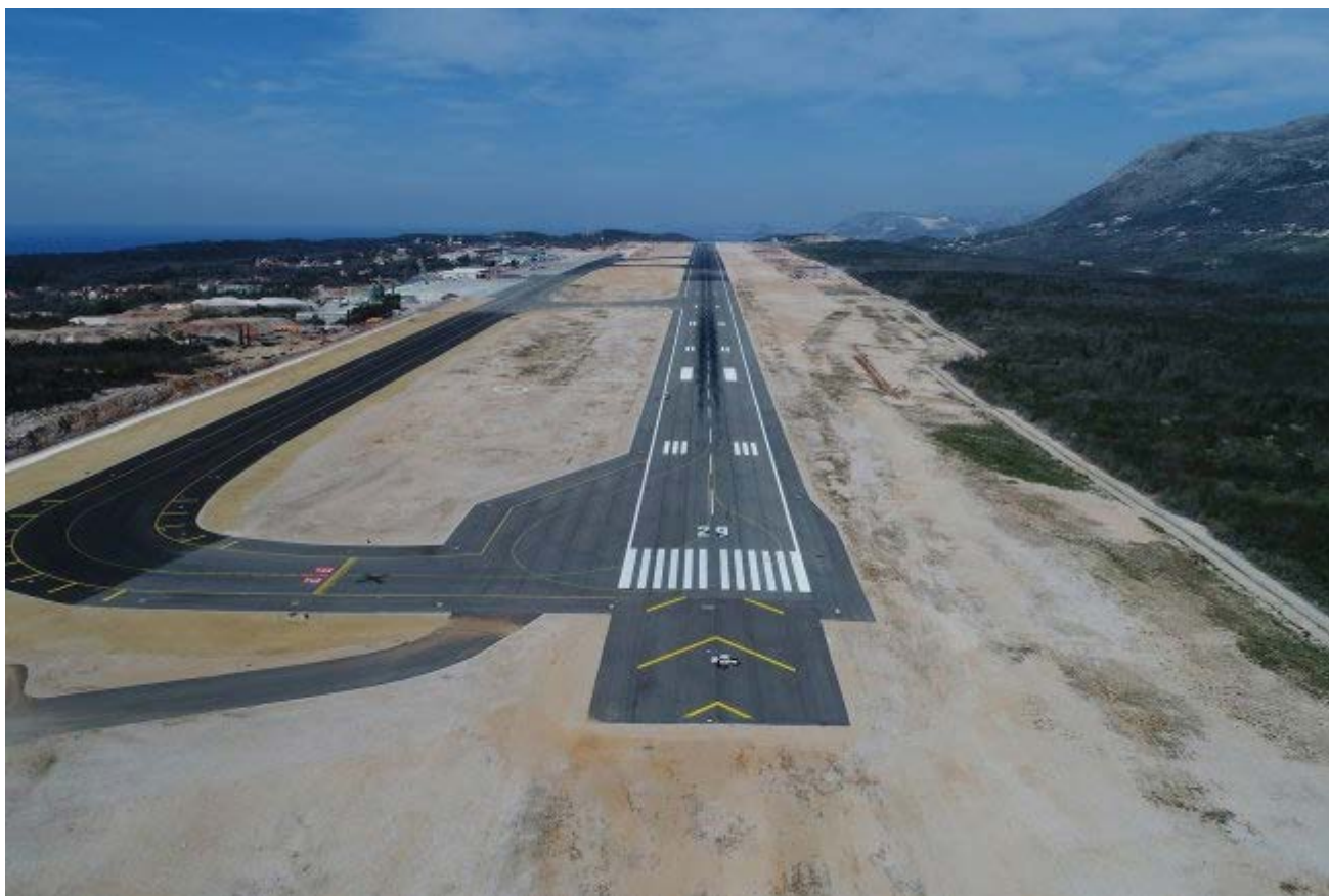
Slika 2. Infrastruktura građenja Zračne luke Dubrovnik [2]
