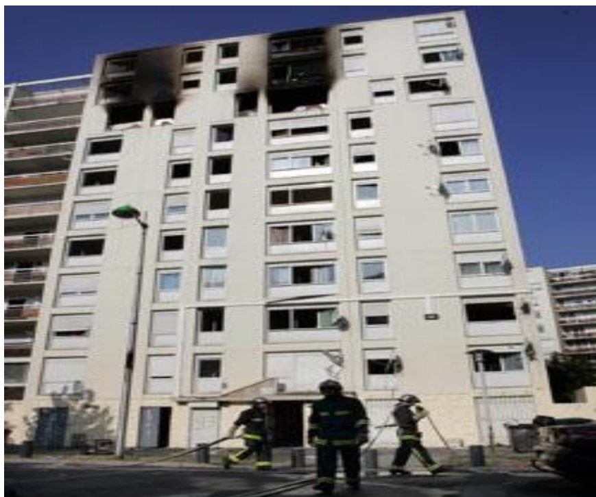
Sl.1. Posljedice požara na višem objektu
