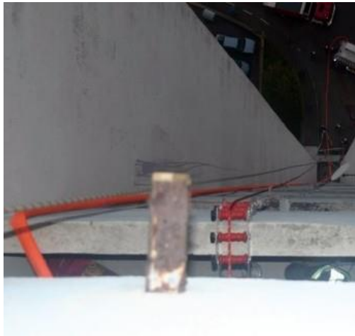
Sl.8. Postavljena vertikala v.t.
