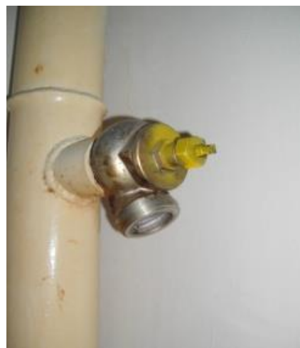
Sl.13. Hidrantski priključak ispred ulaza u zgradu Sl.14. Neispravni zidni hidrant
