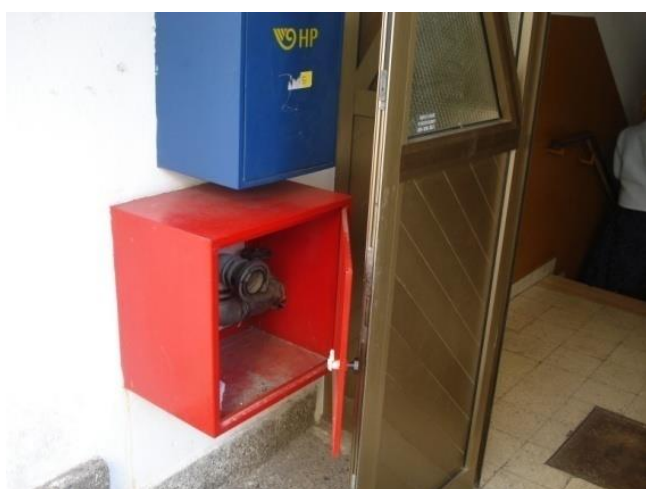
Sl.13. Hidrantski priključak ispred ulaza u zgradu Sl.14. Neispravni zidni hidrant
