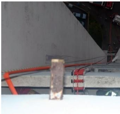
Sl.8. Postavljena vertikala v.t.
