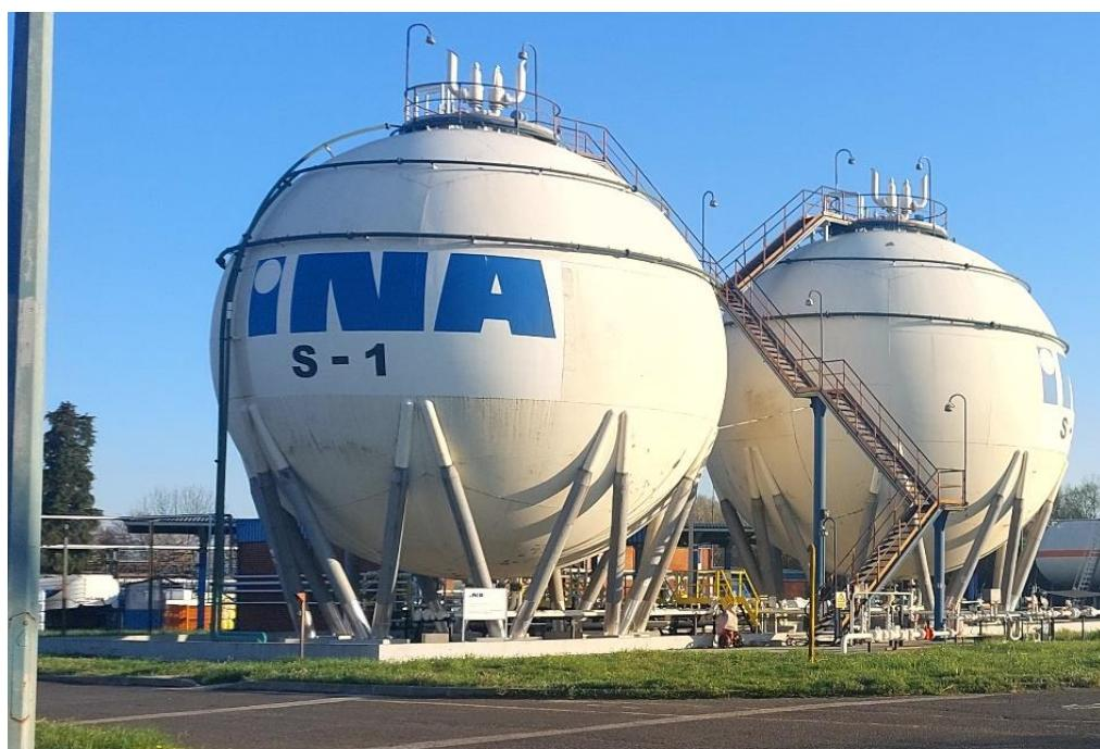
Slika 12. Kuglasti spremnik [8]
