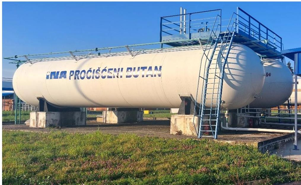
Slika 11. Horizontalni cilindrični spremnik [8]
