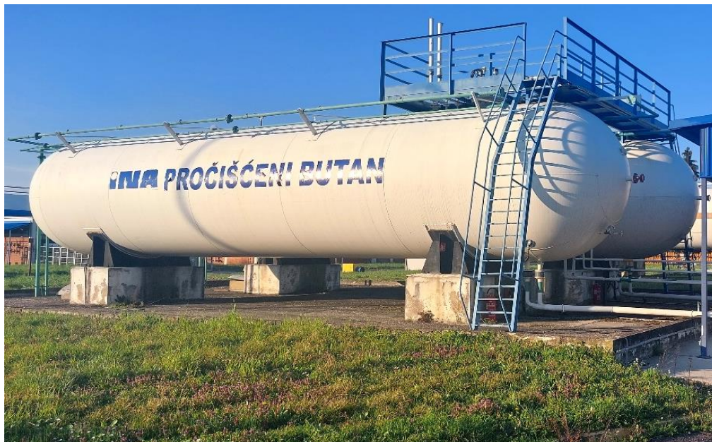
Slika 11. Horizontalni cilindrični spremnik [8]
