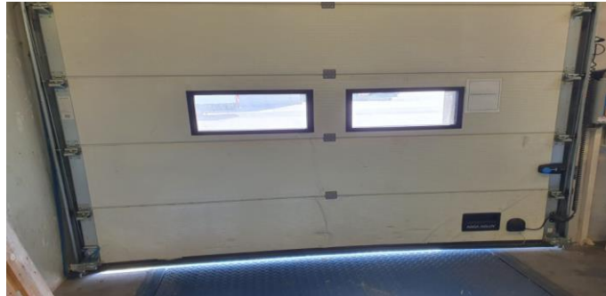
Sl. 24. Prikaz industrijskih sekcijaskih vrata [Vlastita fotografija]
