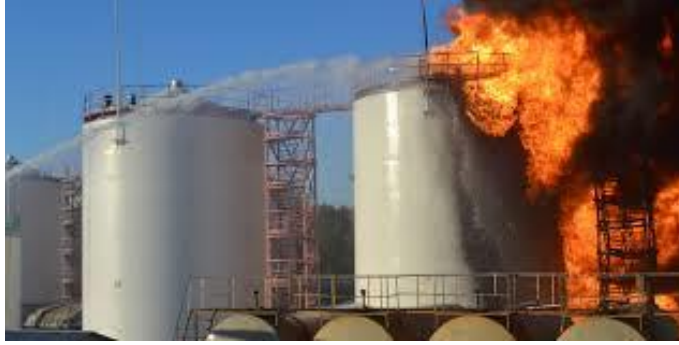
Slika 19. Požar spremnika goriva u Kijevu
