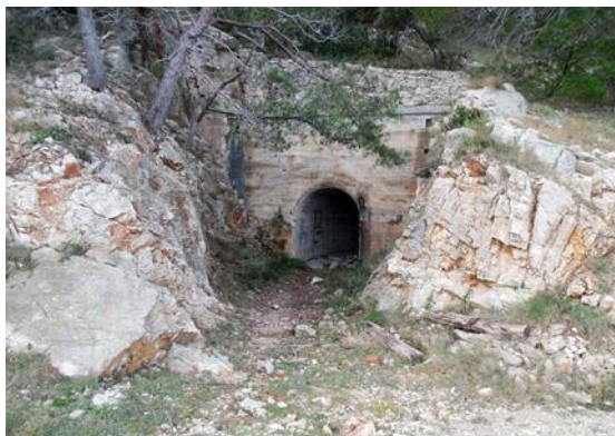
Slika 8. Skladišni objekt vrste P
