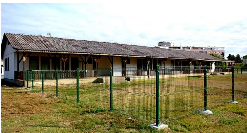
Slika 7. Dječji vrtić Rakovac prije rekonstrukcije [22]
