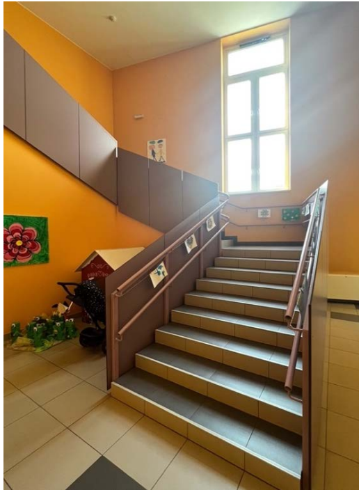
Slika 11. Unutarnje stubište u dječjem vrtiću Rakovac, vlastiti izvor autora
