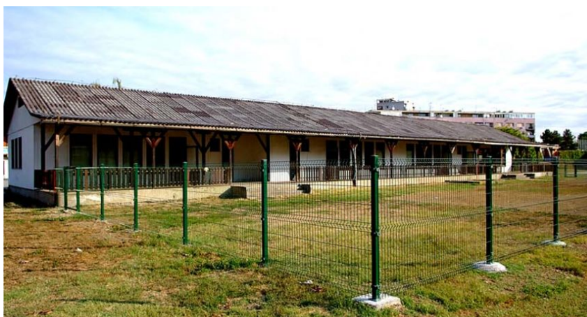
Slika 7. Dječji vrtić Rakovac prije rekonstrukcije [22]
