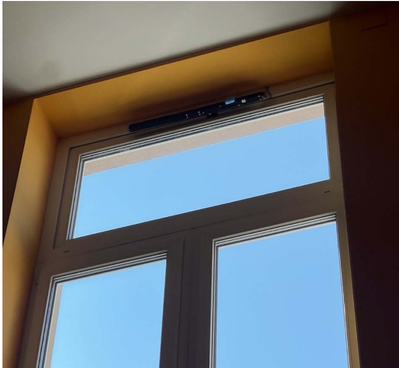
Slika 17. Mehanizam za automatsko odimljavanje otvaranjem prozora, vlastiti izvor autora
