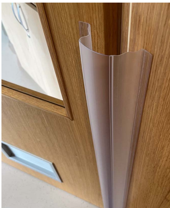
Slika 3. Zaštita na vratima od priklještenja prstiju, vlastiti izvor autora
