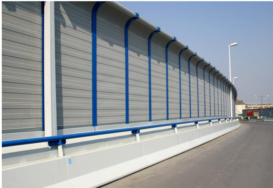
Slika 6.2. Aluminijски paneli
