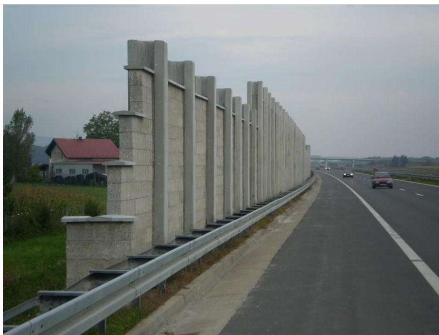
Slika 6.1. Zidovi za zaštitu od buke
