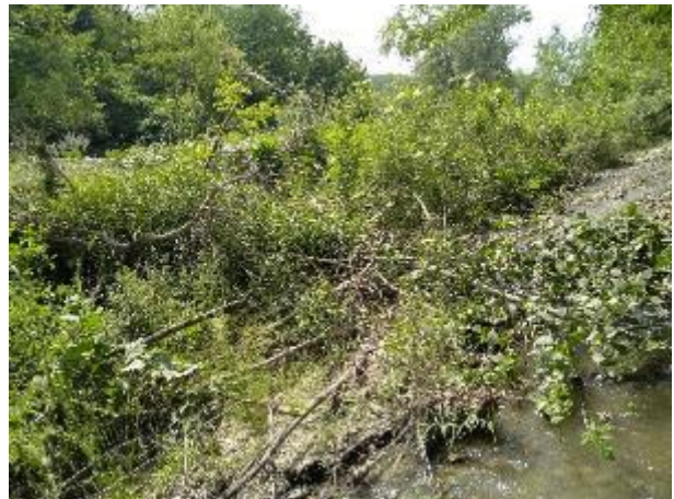
Slika 85. Vegetacija oborena u potok pri proširivanju ceste
