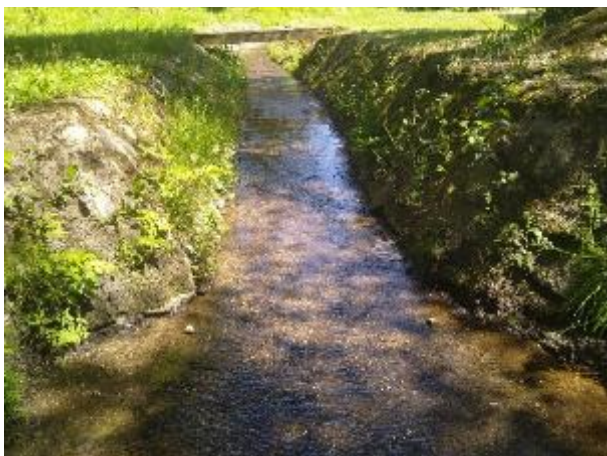
Slika 24. Utvrđeni dio vodotoka, mali ribnjak
