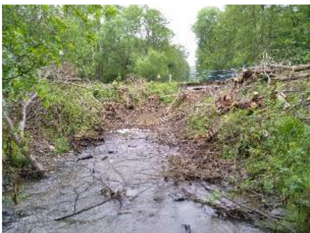
Slika 80. Čišćenje kanala kod akumulacije Novo Zvečevo
