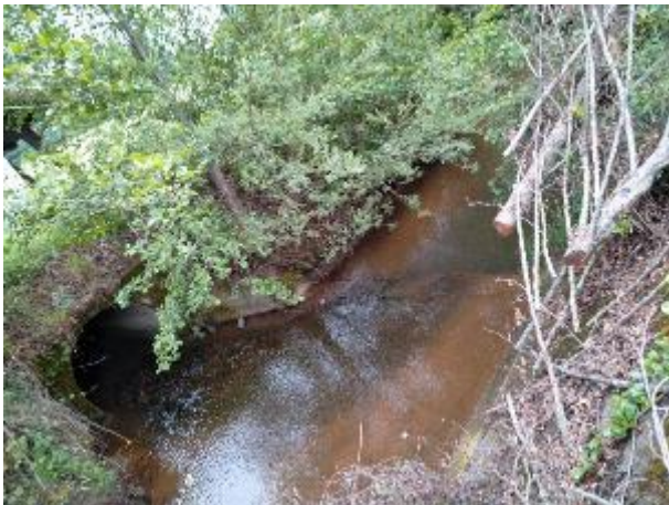
Slika 9. Ispust akumulacije Novo Zvečevo
