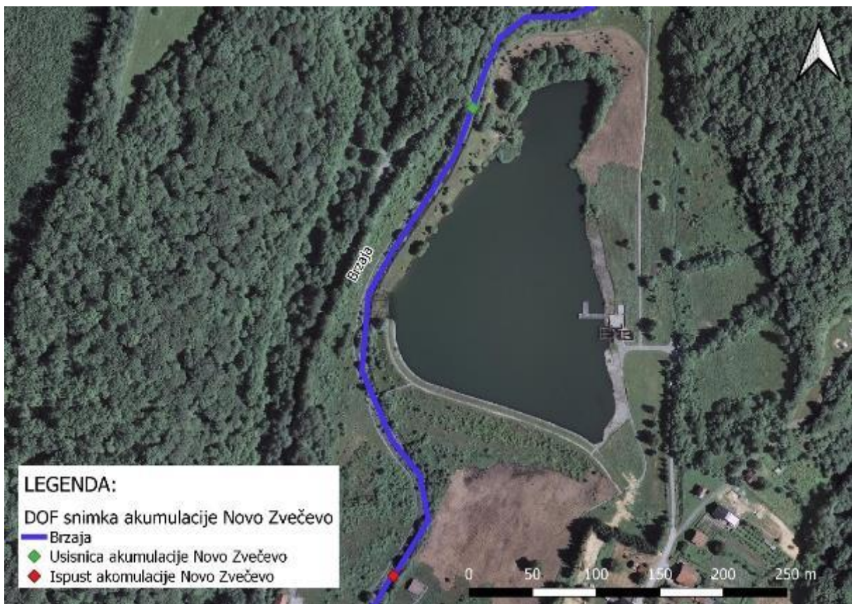
Slika 19. Akumulacija Novo zvečevo s oznakama usisnice i ispusta
