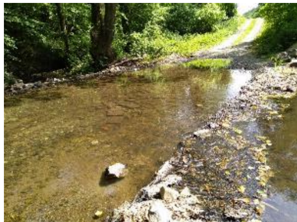
Slika 41. Utvrđeni prijelaz koji zadržava mulj
