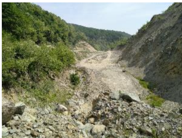
Slika 44. Aktivni kamenolom Žervanjska, vodotok u sredini
