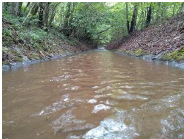
Slika 79. Utvrđena obala i dno uz akumulaciju Novo Zvečevo
