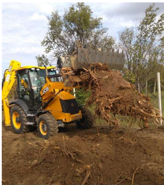
Slika 3. Vadenje panja pomoću radnog stroja
