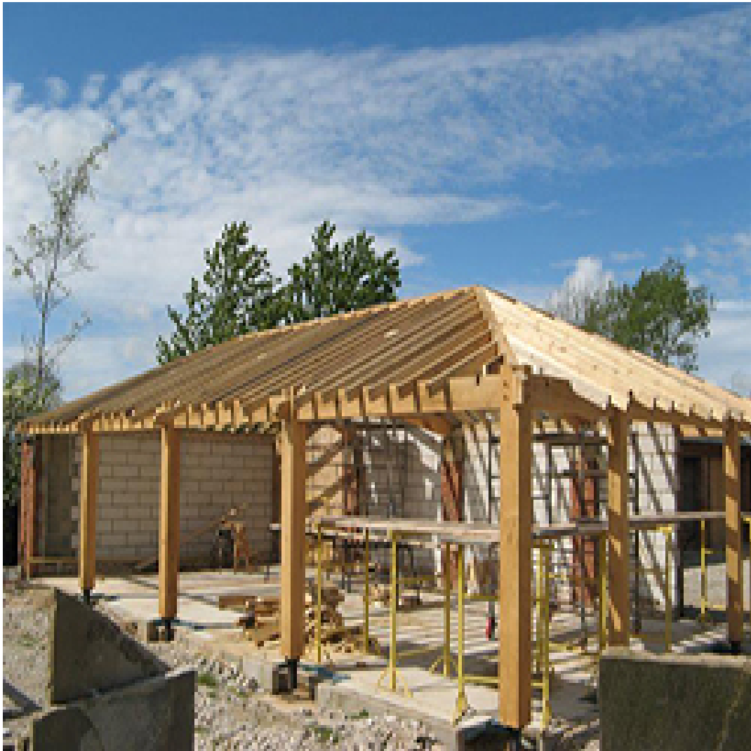
Slika 10 Primjer konstrukcije izrađene s hrastom [10]
